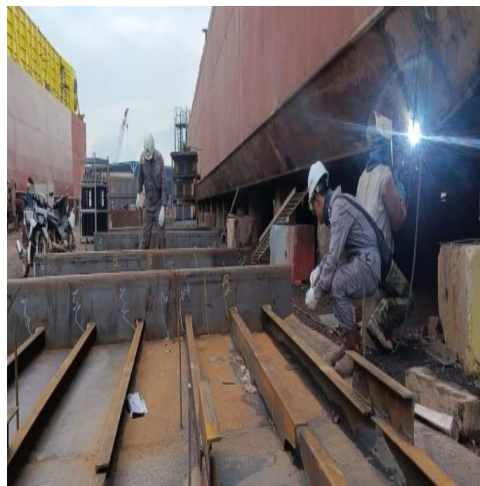
Gambar 2. 10 inspect welding pada longitudinal bulkhead
