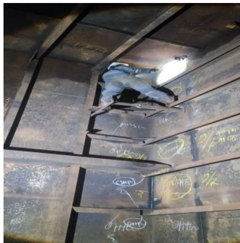
Gambar 2. 15 proses Inspect welding pada tangki kapal tongkang
