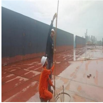
Gambar 3. 13 Proses pengukuran air didalam selang dan pengukuran dengan pressure gauge gauge
