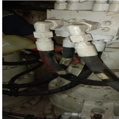
Gambar 2. 67 proses penggantian oli pedestal
