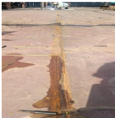
Gambar 2. 20 proses inspect welding pada bagian side shell
