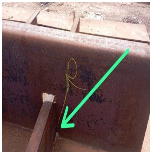
Gambar 2. 6 proses Inspect welding pada bagian deck
