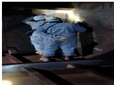
Gambar 2. 22 proses air test pada kapal tongkang
