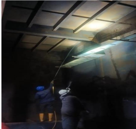
Gambar 2. 1 Proses air test dalam tangki
