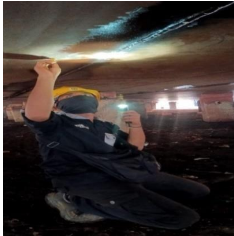
Gambar 2. 21 proses air tes pada bagaian bottom
