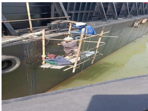
Gambar 2. 17 proses pemasangan plimsoll mark
