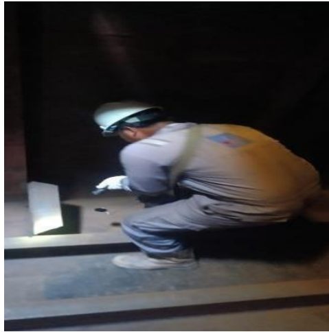
Gambar 2. 8 proses Inspect welding tangki pada kapal tongkang
