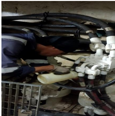
Gambar 2. 66 Proses penggantian oli pedestal
