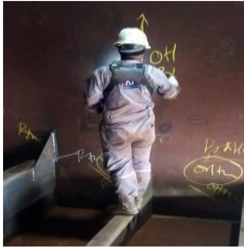
Gambar 2. 14 proses Inspect welding pada tangki kapal tongkang
