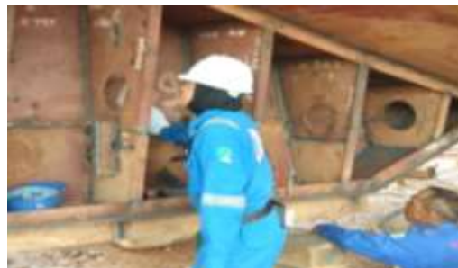
Gambar 2. 114 Leveling Skeg
