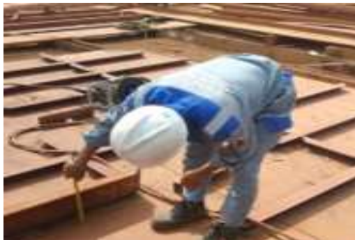
Gambar 2. 57 Scantling Check dan Fit Up
