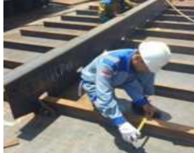
Gambar 2. 82 Scantling Check dan Fit Up
