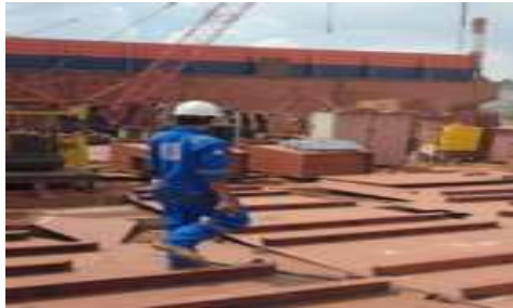
Gambar 2. 90 Scantling Check dan Fit Up
