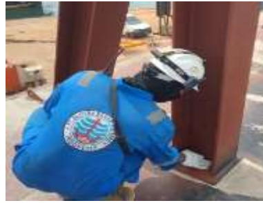
Gambar 2. 77 Visual Final Inspection pada sideboard
