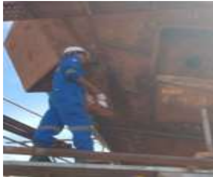
Gambar 2. 69 Air Pressure test Internal dan Eksternal
