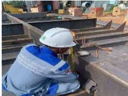
Gambar 2. 52 Scantling Check dan Fit Up
