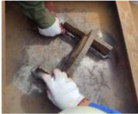
Gambar 3. 11 Proses pembersihan setelah disemprotkan penetran
