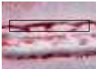
Gambar 3. 14 Cacat las undercut
