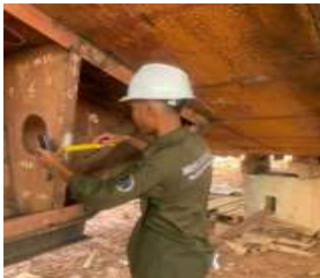
Gambar 2. 51 Scantling Check dan Fit Up
