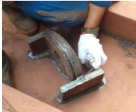
Gambar 3. 9 Proses pembersihan menggunakan clenear
