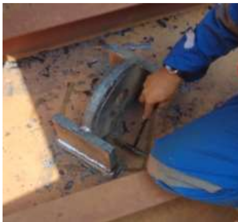
Gambar 3. 8 Proses pembersihan menggunakan sikat kawat
