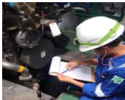
Gambar 2. 43 Pengecekan Vibration pada kapal
