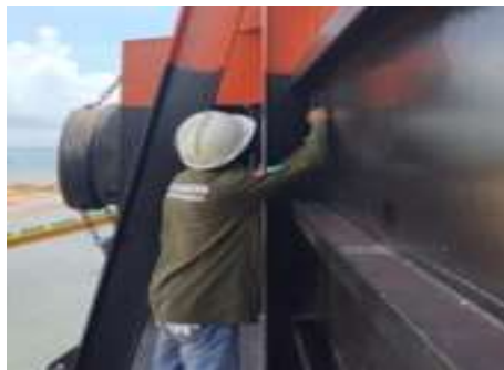
Gambar 2. 78 Visual Final Inspection pada sideboard
