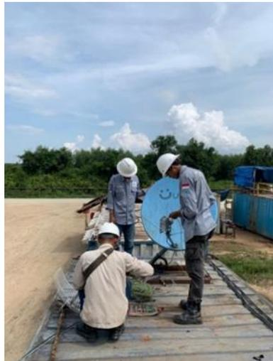
Gambar 3.1 Pemasangan VSAT
