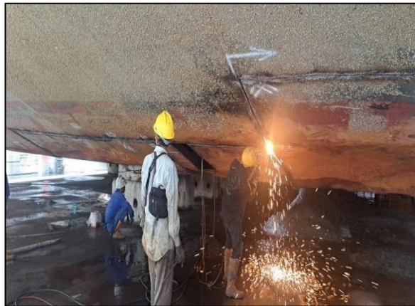
Gambar 3.3 Gambar Pemotongan Plate
