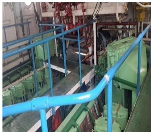
Gambar 2.47 Relling Ruang Mesin
