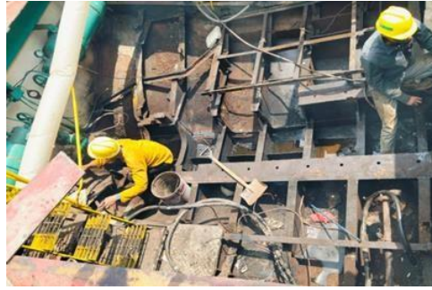
Gambar 2.14 Pembongkaran enggin room CB.Ab2
