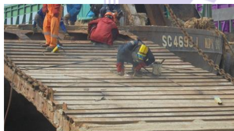
Gambar 2.34 Replaiting Ramp door tongkang KPS
