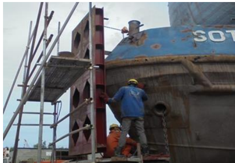
Gambar 2.33 Pemasangan Fuser TB.Sotalia Dolphin
