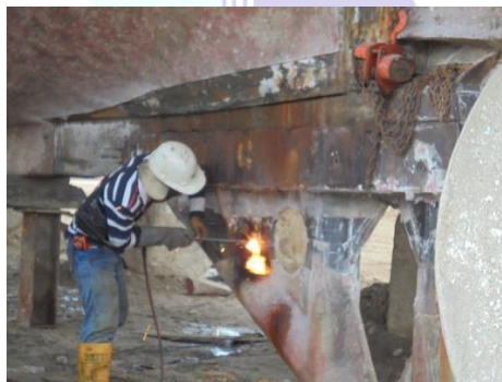
Gambar 2.32 Replaiting lunas kapal KG. 0451 TS
