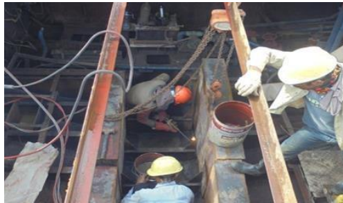
Gambar 2.25 Replaiting kapal CB.Ab2.
