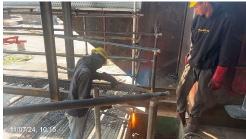
Gambar 2.4 Perbaikan roller walkway jembatan kapal Zhe Zhuang 6 Hao
