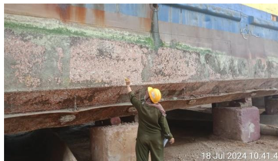
Gambar 3.1. pemeriksaan visual dilapangan
