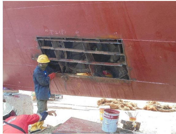
Gambar 2.26 inspek pada repair plate
