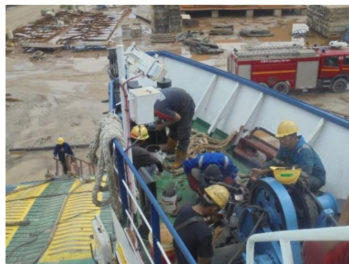
Gambar 2.44 perbaikan pipa hydrolic
