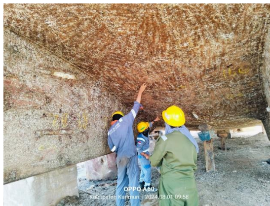
Gambar 2.22 UT. Thickness pada bagian bottom
