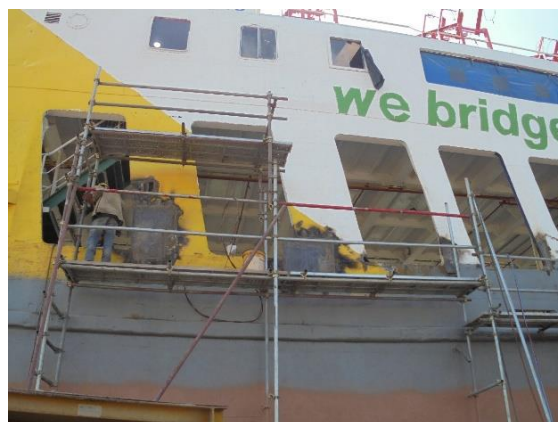
Gambar 2.31 Inspek pekerjaan repair
