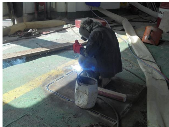
Gambar 2.35 Inspek pekerjaan repair
