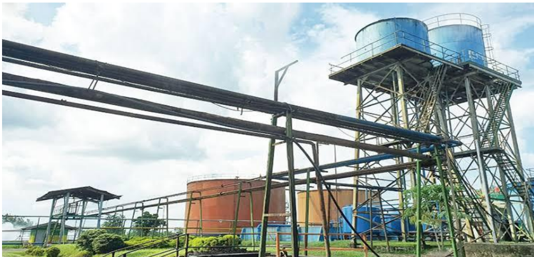
Gambar 2.4 Pabrik PT. Perkebunan Nusantara IV Regional III
