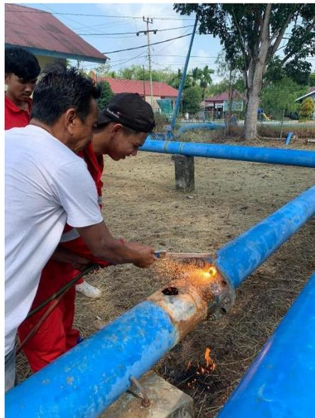
Gambar 3 2 pengelasan pada pipa
