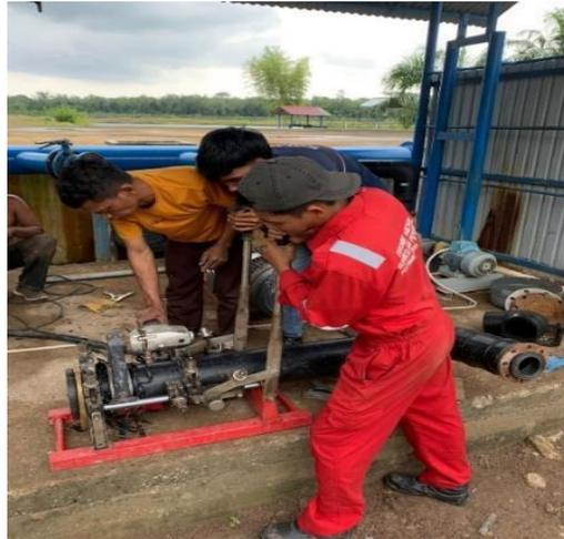
Gambar 3 3 pemasangan pipa
