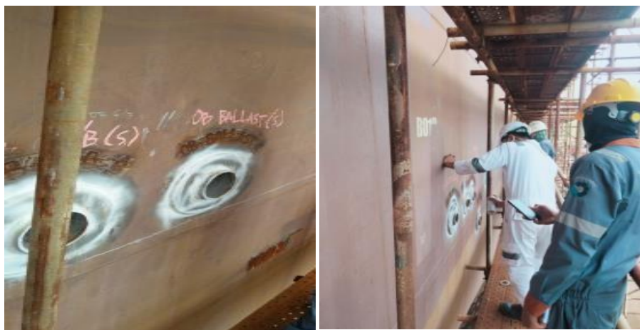
Gambar 2.35 Melakukan atau mengikuti proses Inspeksi Non Destructive Tes (NDT) bagian overboard
