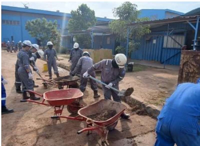
Gambar 2.18 House Keeping dan dilanjutkan survey progress pembuatan kapal Gearless Mvp.
