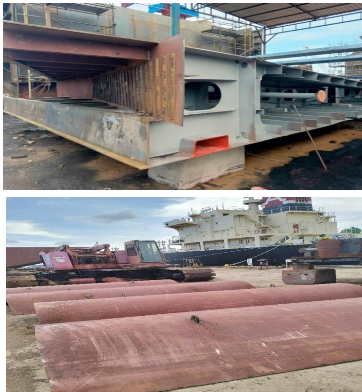
Gambar 2.31 Daily report progres pemasangan side sile bagian bottom kapalgearless
