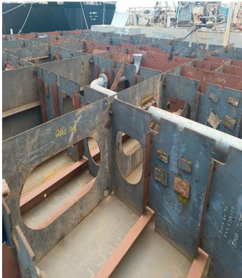
Gambar 2.29 melanjutkan survey progres pembuatan bottom and port- starboard kapal gearless
