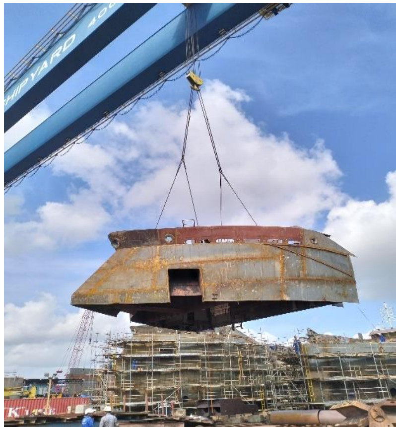
Gambar 2.27 melakukan survey pemasangan assembly pada bagian Haluan kapal gearless
