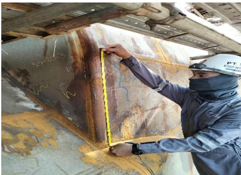
Gambar 2.36 Melakukan pengecekan dan pengukuran anchor pocet dan general house keeping
