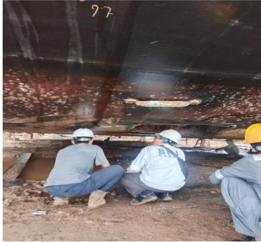
**Gambar 2.6** pemeriksaan hasil pemotongan plat pada buttom
