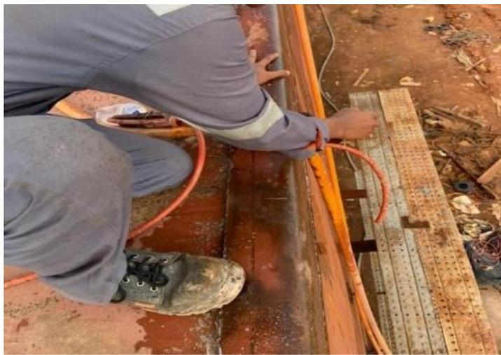
Gambar 2 30 Melakukan Air Test eksternal
