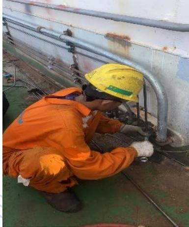
*Gambar 2.22 Pemasangan Pipa Hydrolic Winch Jangkar*
