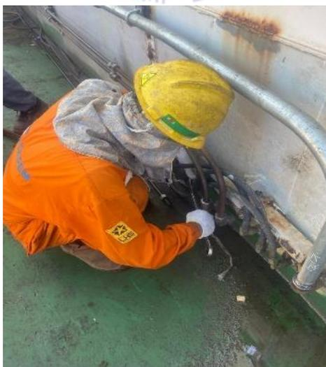
*Gambar 2.8 Pemasangan Pipa Hydraulic Winch*
