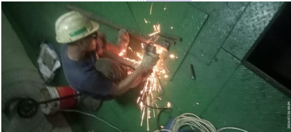
*Gambar 2.13 Finishing Pemasangan Pipa MFO*
