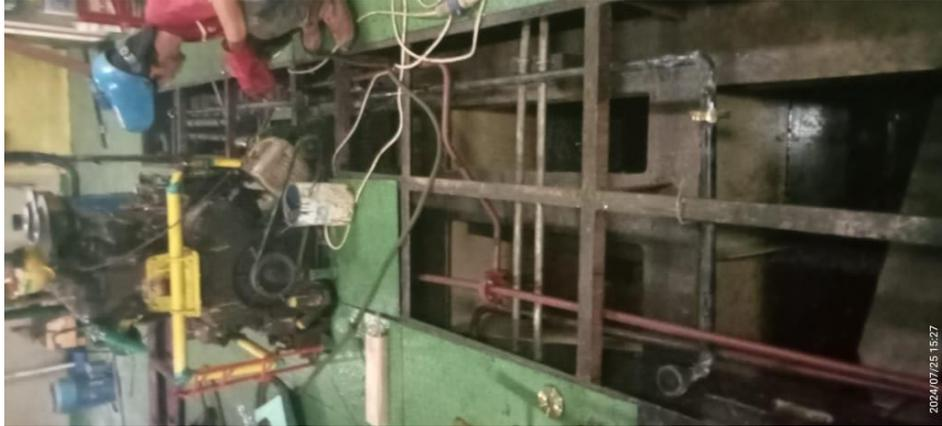
*Gambar 2.12 Pemasangan Pipa MFO*
