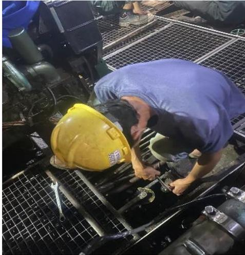
*Gambar 2.10 Pembongkaran Valve Air Laut*
