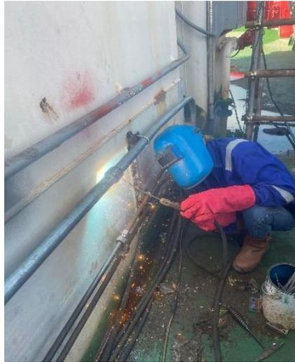
*Gambar 2.7 Pemasangan Pipa Hydraulic Winch*
