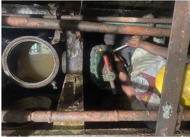
*Gambar 2.9 Pembongkaran Valve Saringan Sea Chest*
