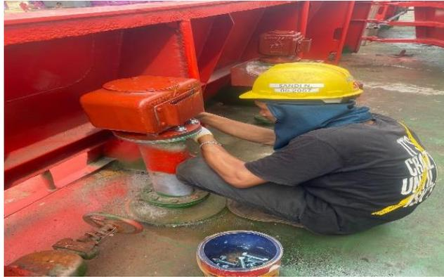
*Gambar 2.5 Pemasangan Valve Air Vant*
