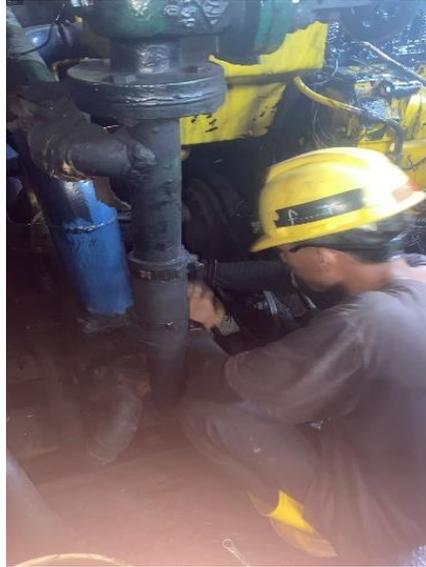
*Gambar 2.15 Pembongkaran Pipa Air Tawar*
