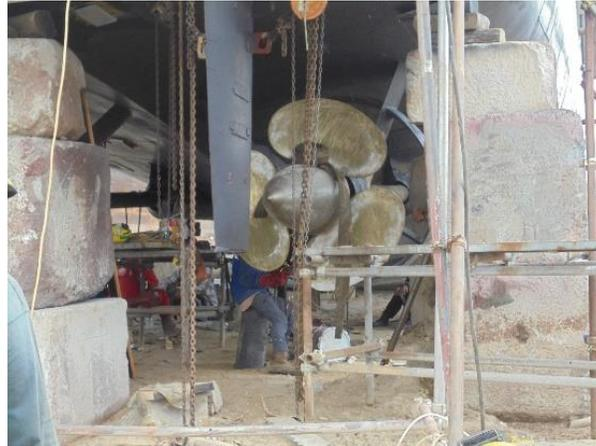
*Gambar 2.32 Pemasangan Propeller*
