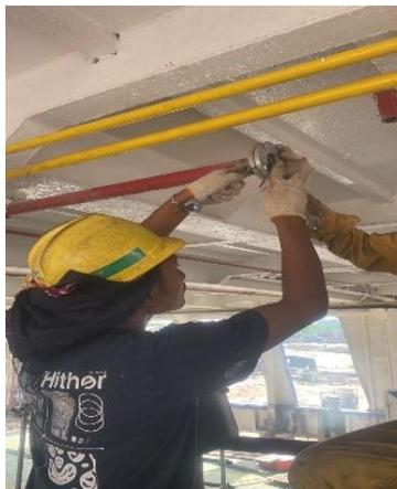
*Gambar 2.27 Pemasangan Flang Pada Pipa Pemadam*
