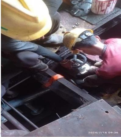
*Gambar 2.24 Pemasangan Pipa Fresh Water*
