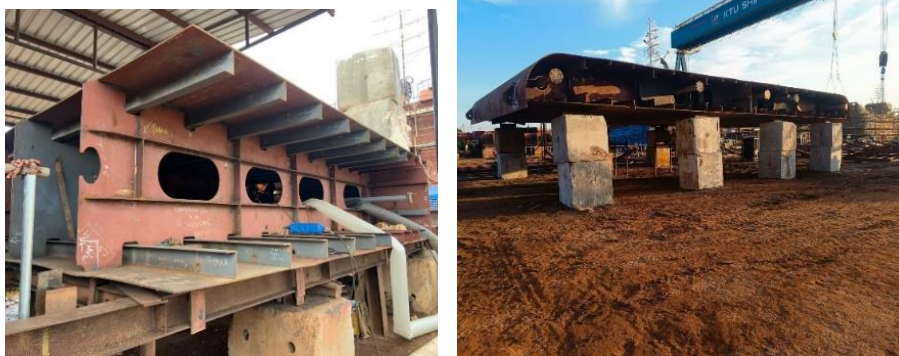
Gambar 2.28 Melakukan survey proses pembuatan Bottom, Prot Side and Starboard pada kapal Gerless.
