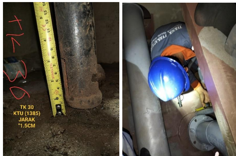
Gambar 2.21 Melakukan pengukuran dan pengecekan jarak pemasangan gap pipe pada tangki sounding kapal Gearless .
