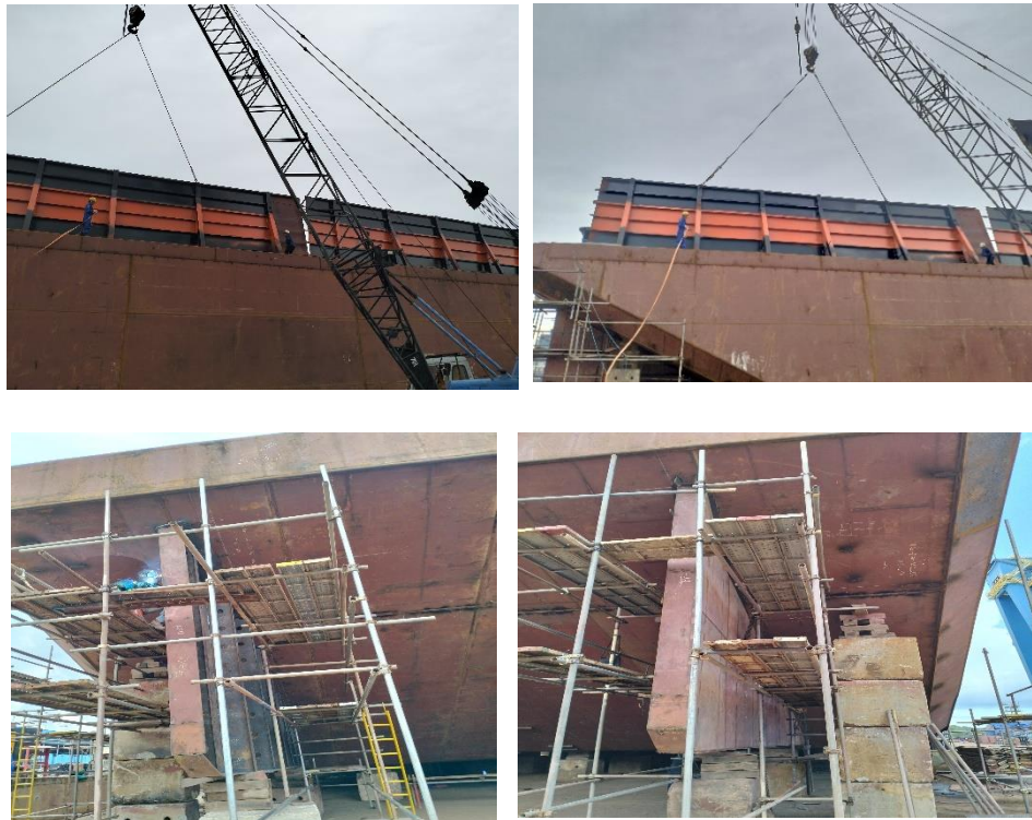
Gambar 2.53 Mengamati proses pemasangan Skeg and Sideboard pada kapal tongkang.
