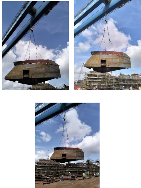
Gambar 2.27 Melakukan survey pemasangan Assembly pada bagian Haluan kapal Gearless.
