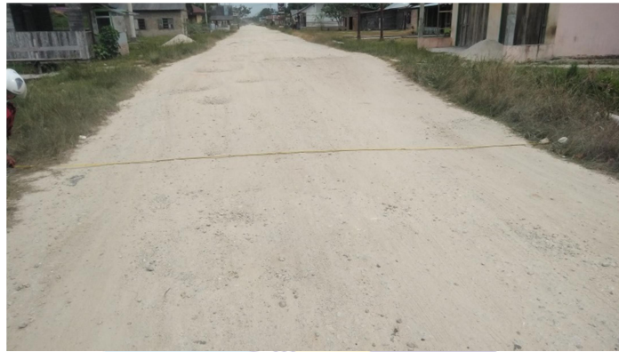
Gambar 1.1 Kondisi Eksisting Sumber : Dokumentasi lapangan
