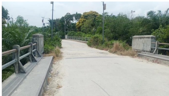
Gambar 1. 1 Eksisting Jembatan (Sumber: Dokumentasi Lapangan)
