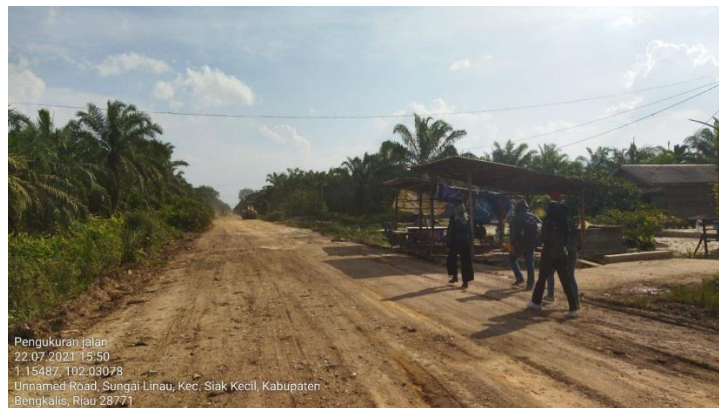
Gambar 1.1 Kondisi ekisting jalan (Sumber : Dokumentasi lapangan)
