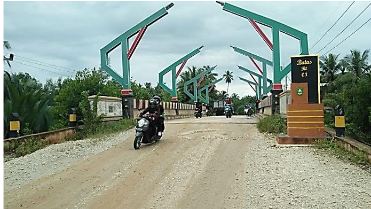
Gambar 1.1. Kondisi eksisting jembatan sungai terkul (Sumber : Dokumentasi, 2021)
