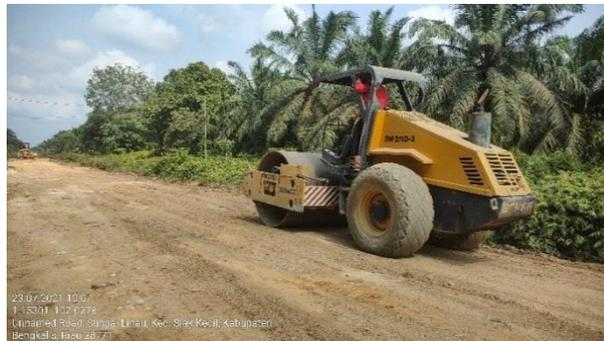
Gambar 3.6. Pemasatan menggunakan vibro roller
