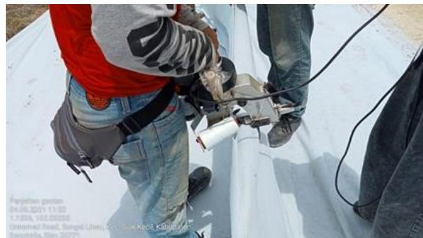
*Gambar 3.8. Penjahitan Geotextile
