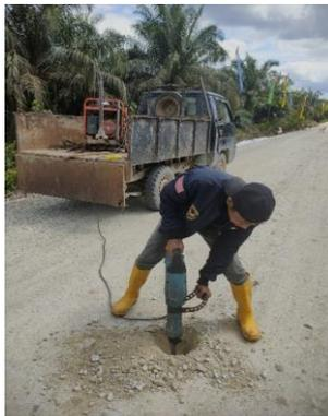
*Gambar 3.11. Pembuatan Lubang Core Base B
