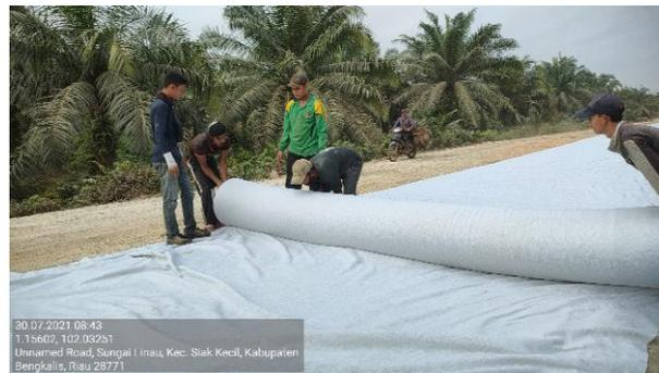
*Gambar 3.7. Pembentangan Geotextile
