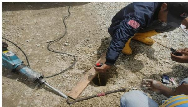
*Gambar 3.17. Pengukuran Kedalaman Base A
