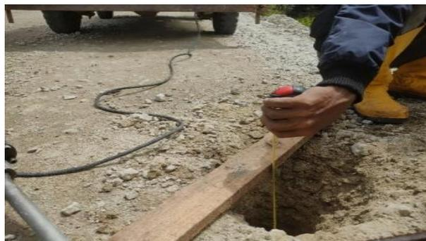
*Gambar 3.12. Pengujian Core Base B
