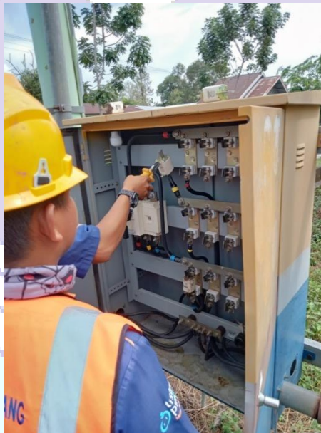
Gambar 2. 18 Penggantian NH Fuse (Sumber : Dokumentasi.2021)
