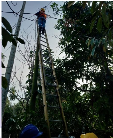
Gambar 2. 20 Gangguan SR pelanggan lost kontak (Sumber : Dokumentasi.2021)
