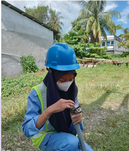
Gambar 2. 12 Mengganti fuse link CO( cut out ) (Sumber : Dokumentasi.2021)
