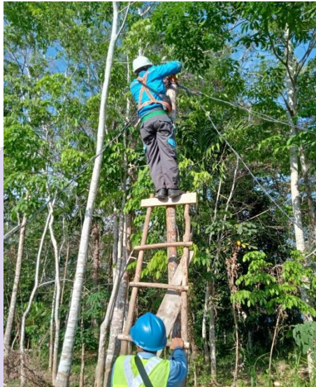
Gambar 2. 11 pemasangan kabel Saluran Rumah (SR) (Sumber : Dokumentasi.2021)
