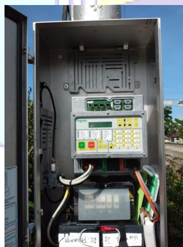
Gambar 2. 27 Mengatasi RC ( Recloser ) trip (Sumber : Dokumentasi.2021)
