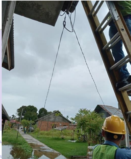
Gambar 2. 23 Pemasangan kabel SR yang putus (Sumber : Dokumentasi.2021)
