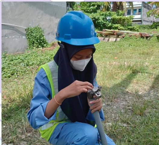
Gambar 3. 6 Mengganti fuse link cut out (CO) (Sumber : Dokumentasi.2021)
