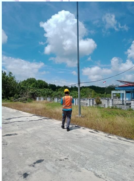
Gambar 2. 13 mengatasi kabel SR yang kendor (Sumber : Dokumentasi.2021)
