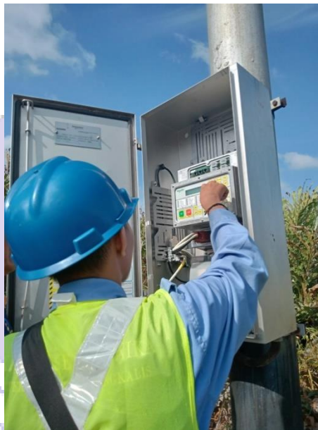
Gambar 2. 14 mengatasi RC ( Recloser ) Trip (Sumber : Dokumentasi.2021)
