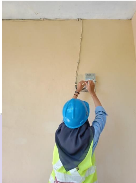
Gambar 3. 2 Mengganti MCB (Sumber : Dokumentasi.2021)
