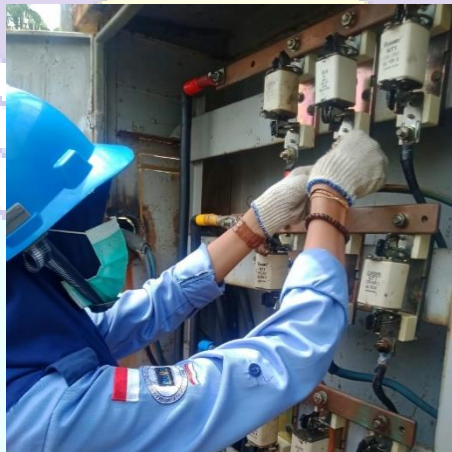
Gambar 2. 42 Melakukan perawatan PHBTR (Sumber : Dokumentasi.2021)
