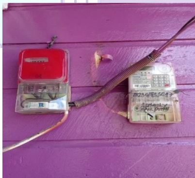
Gambar 2. 19 Pemasangan meter dumi atau meter sementara 17. (Sumber : Dokumentasi.2021)
