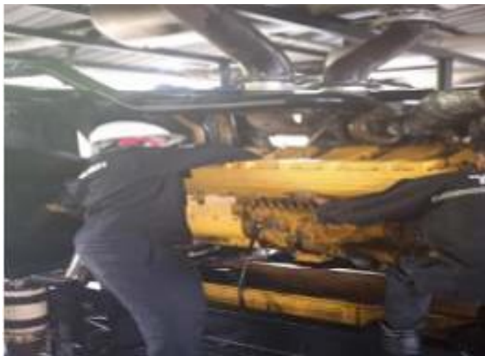
Gambar 2.26 membuka baut penutup cilynder ( Sumber : PT.MEGAPOWER MAKMUR Tbk.2021)
