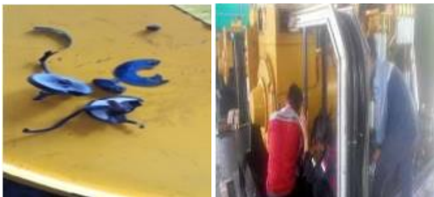
Gambar 2.6 Penggantian pasistor dan dioda ( Sumber :PT. MEGAPOWER MAKMUR Tbk.2021)
