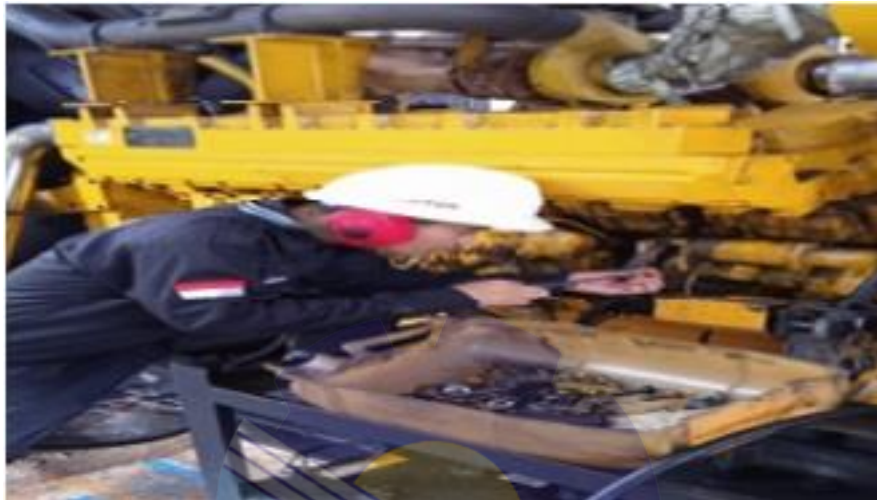
Gambar 2.27 membuka baut pengencang pengecas aki ( Sumber : PT.MEGAPOWER MAKMUR Tbk.2021)
