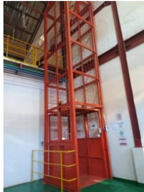
Gambar 3.3. Elevator Barang (Lift Barang) Sumber : Dokumentasi Pribadi di PT. Cassia Co-op
