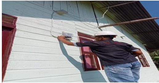
Gambar 2.9 pergantian Kwh meter (Sumber: dokumentasi penulis, 2021)
