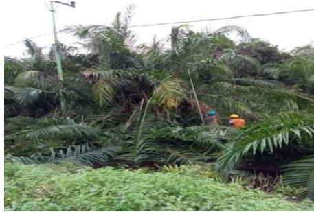
Gambar 2.14 Pembersihan jaringan (Sumber: dokumentasi penulis, 2021)
