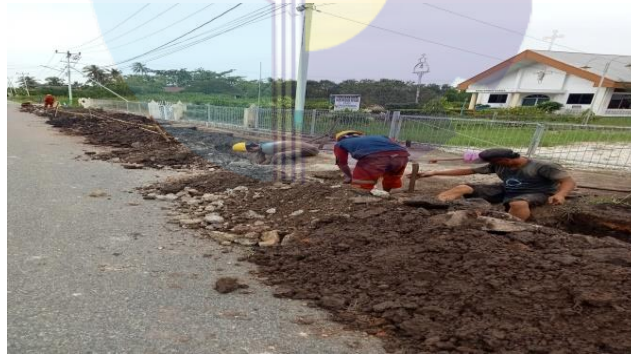
Gambar 2.2 pemasangan kabel tanah (Sumber: dokumentasi penulis, 2021)
