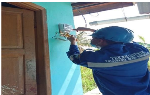
Gambar 2.12 pergantian Kwh meter (Sumber: dokumentasi penulis, 2021)
