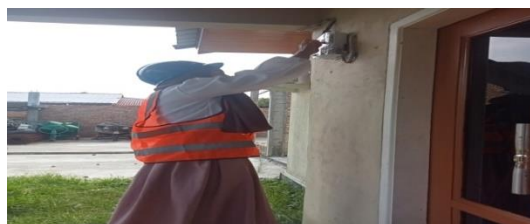
Gambar 2.11 pengaktifan Kwh meter (Sumber: dokumentasi penulis, 2021)
