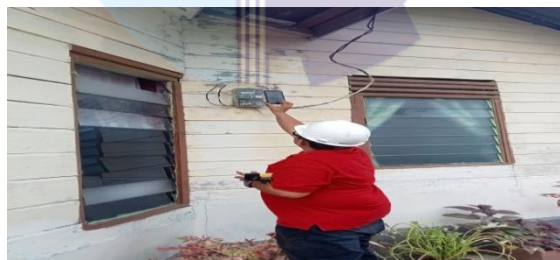
Gambar 2.13 pengaktifan kwh meter. (Sumber: dokumentasi penulis, 2021)
