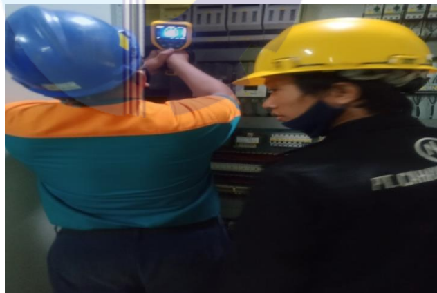
Gambar 2.4 Pengecekan kabel power incaming dari mccb ke contactor.
