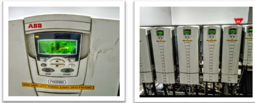
Gambar 3.1 Panel Plc (Sumber: Dokumentasi Penulis, 2021)
