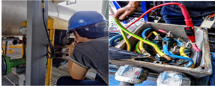
Gambar 2.7 Actuotor Selenoid Vesto (Sumber: Dokumentasi Penulis, 2021)
