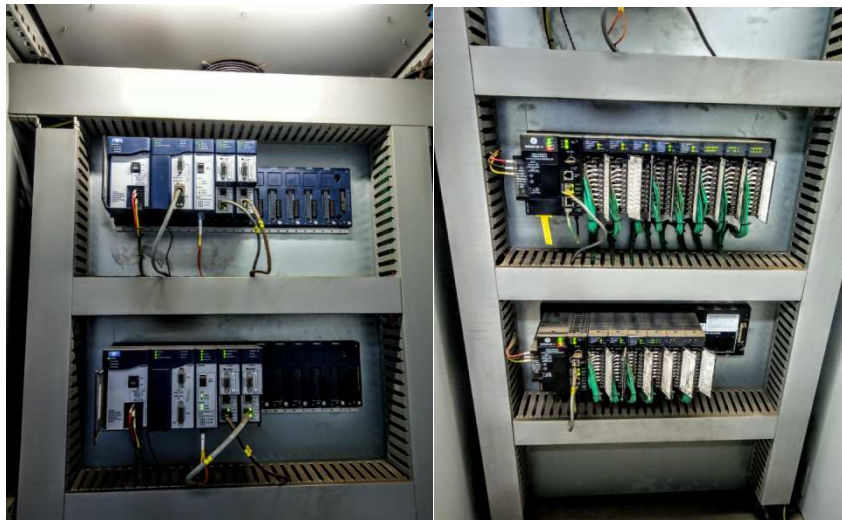
Gambar 2.9 Rack Plc dan Modul Plc (Sumber: Dokumentasi Penulis, 2021)
