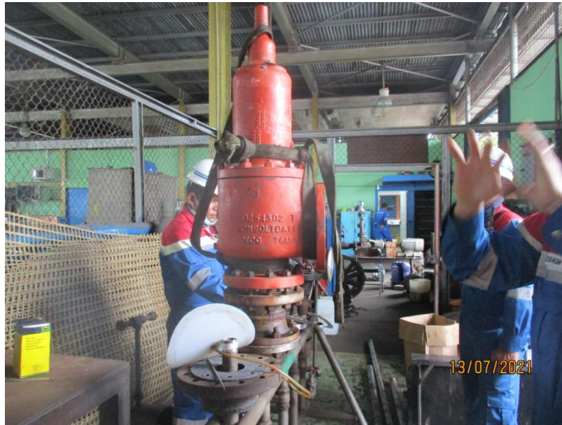
Gambar 1. Hidrant Test (Uji Kebocoran Valve) Sumber : (Dokumen Praktikan)
