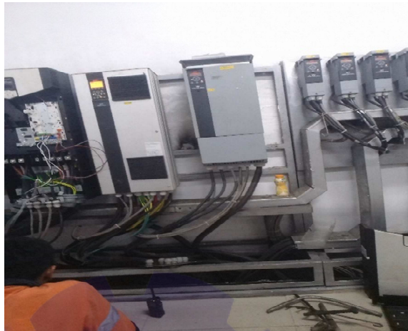
Gambar 11.1 pemasangan kabel sinyal VFD
