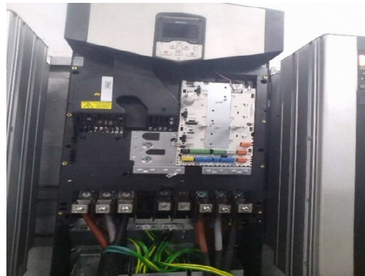
Gambar 4.1 perbaikan komponen pada VFD
