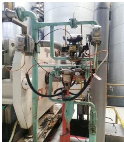
Gambar 2.4 Mengganti pneumatik pada refinery
