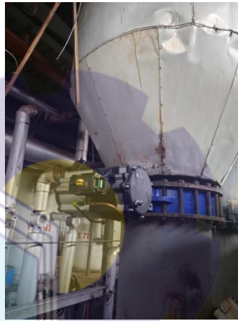
Gambar 2.5 Penggantian Actuator Niagara Filter
