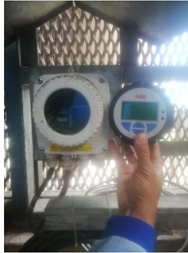
Gambar 2.3 Mengganti Oxygen indicator endura AZ20
