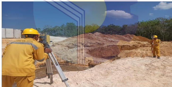
Gambar 3.2:Pekerjaan pengukuran menggunakan total station
