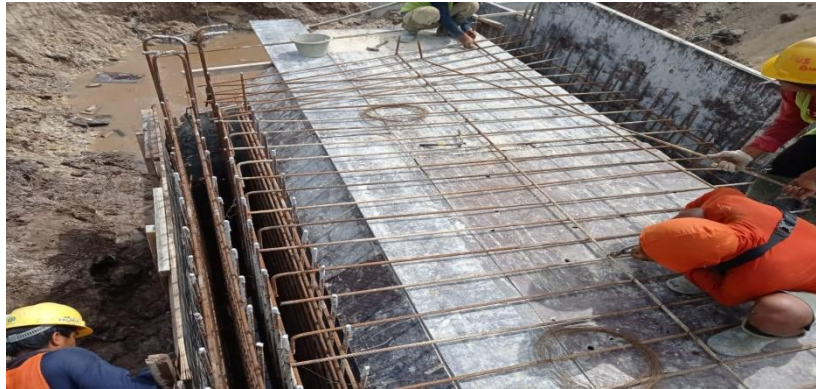
Gambar dokumentasi 3.8: Pekerjaan pengikatan besi Dokumentasi Lapangan (2021)
