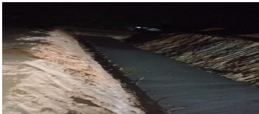
Gambar dokumentasi 3.4:Pekerjaan pengecoran
