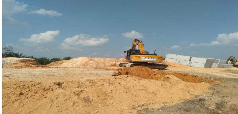
Gambar 3.13: Proses penggalian menggunakan excavator Dokumentasi Lapangan (2021)
