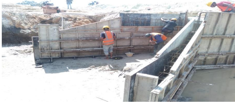
Gambar dokumentasi 3.9:Pekerjaan pemasangan mal Dokumentasi Lapangan (2021)
