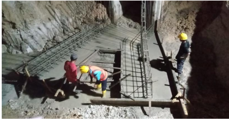
Gambar dokumentasi 3.7 Pekerjaan pengecoran lantai kerja wing wall Dokumentasi Lapangan (2021)
