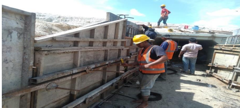
Gambar 3.15:Proses penguncian menggunakan tirotpengunci Dokumentasi Lapangan (2021)
