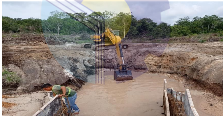
Gambar 3.14: Proses pengurasan air menggunakan excavator Dokumentasi Lapangan (2021)
