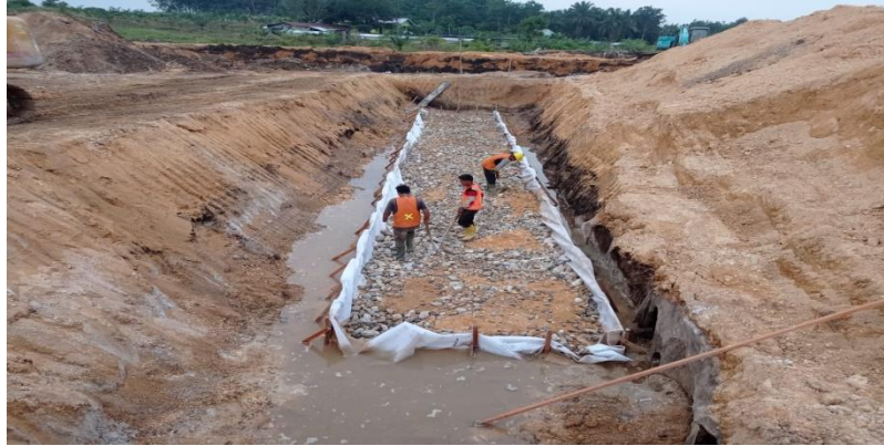
Gambar dokumentasi 3.3 Pekerjaan penimbunan lantai kerja box culvert
