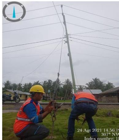
Gambar 2.24 Perbaikan track schoor
