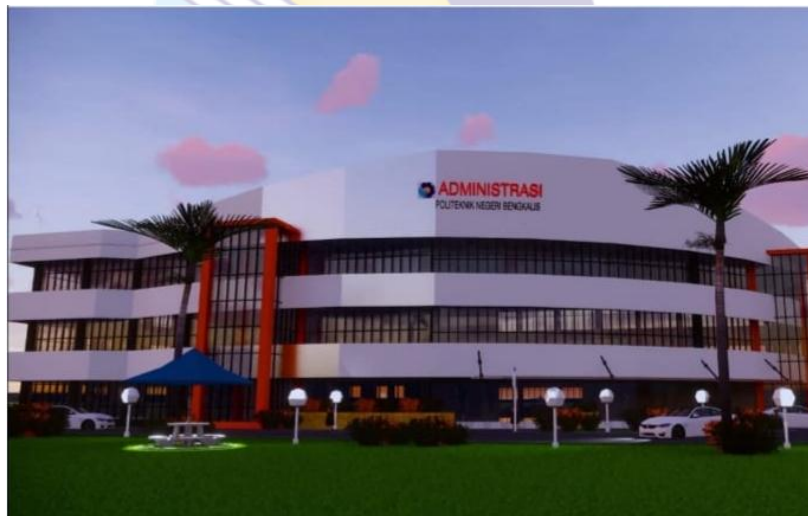
Gambar 1.1. Proyek Gedung Kuliah Terpadu Politeknik Negeri Bengkalis
