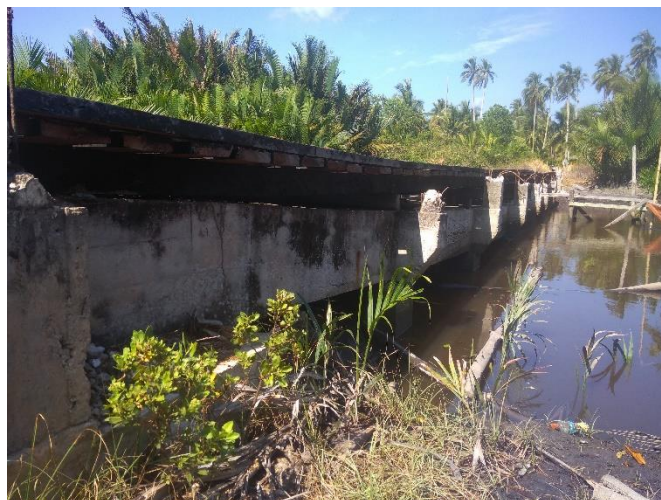
Gambar 1.1 Kondisi eksisting jembatan (Sumber: Dokumentasi lapangan skripsi, 2020)
