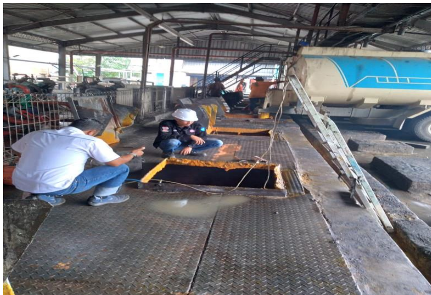
Gambar:Perbaikan bak bongkaran.
