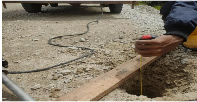
Gambar 3.12. Pengukuran kedalaman Base B (Sumber : Data Lapangan Tahun 2021)
