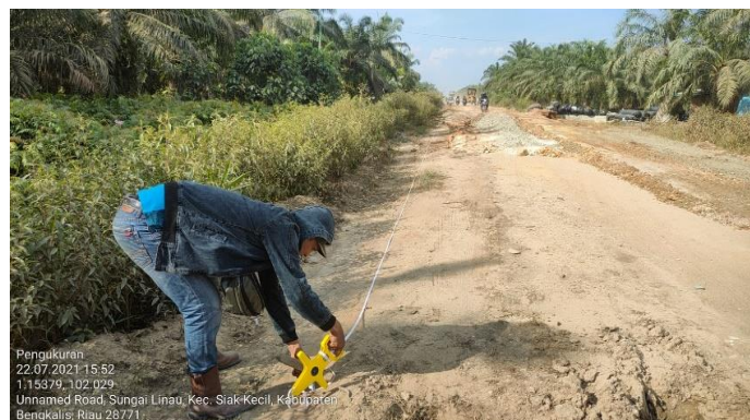
Gambar 3.2. Pengukuran Jalan (Sumber : Data Lapangan Tahun 2021)
