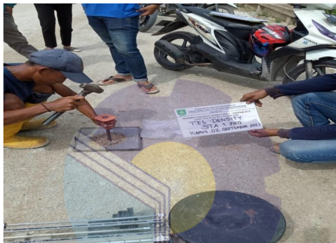
Gambar 4.5. Pengujian Base A (Sumber : Data Lapangan Tahun 2021)
