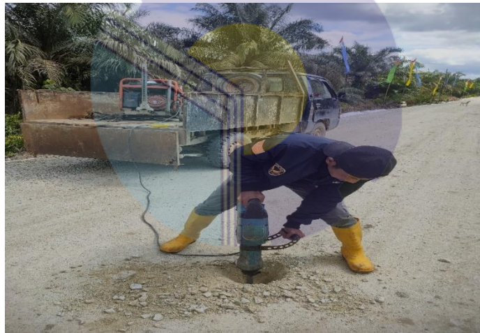
Gambar 3.11. Penge-Core-an Base B (Sumber : Data Lapangan Tahun 2021)
