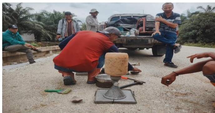
Gambar 3.13. Pengujian Density Base B (Sumber : Data Lapangan Tahun 2021)
