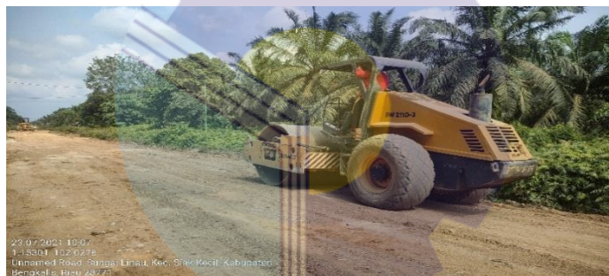
Gambar 3.6. Pematatan (Sumber : Data Lapangan Tahun 2021)
