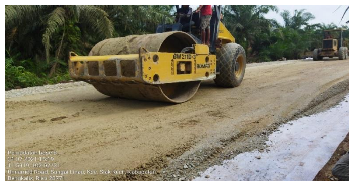
Gambar 3.10. Pemadatan Base B (Sumber : Data Lapangan Tahun 2021)
