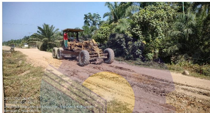
Gambar 3.4. Pemangkasan (Sumber : Data Lapangan Tahun 2021)
