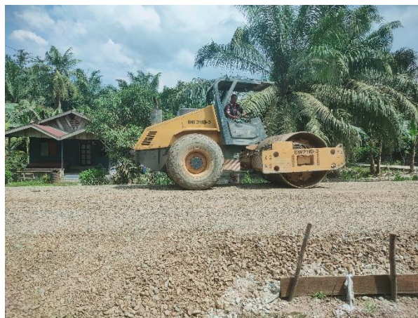
Gambar 4.2 Pemadatan Base A (Sumber : Data Lapangan Tahun 2021)
