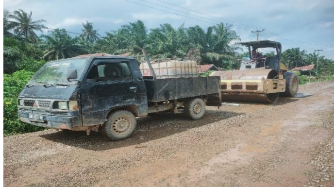
Gambar 3.15. Pematatan Base A (Sumber : Data Lapangan Tahun 2021)
