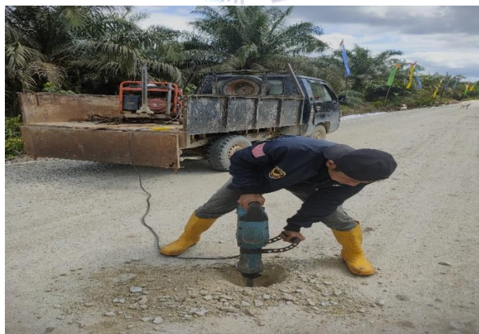
Gambar 4.3. Penge-core-an Base A (Sumber : Data Lapangan Tahun 2021)
