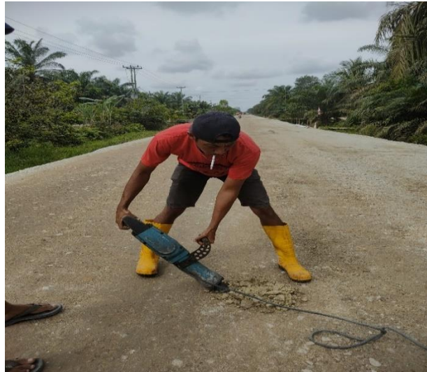
Gambar 3.16. Penge-Core-an Base A (Sumber : Data Lapangan Tahun 2021)
