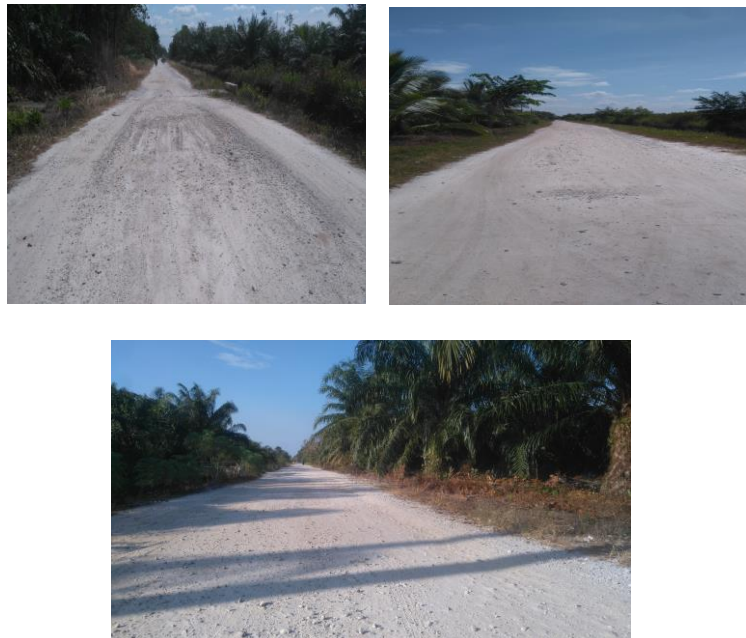
Gambar 1.1 Kondisi Eksisting Sumber : Dokumentasi lapangan
