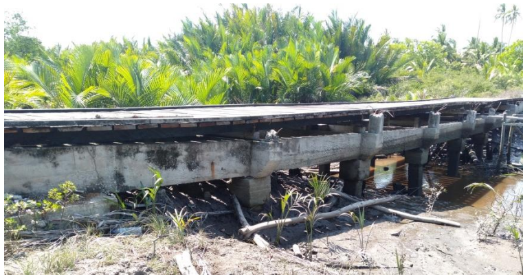
Gambar 1.1 Jembatan Jalan Datuk Laksamana Kecamatan Bukit Batu (Sumber : Dokumentasi lapangan)
