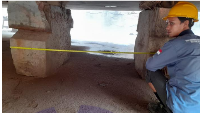
Gambar 2.33 Pengukuran jarak antar Stop Block
