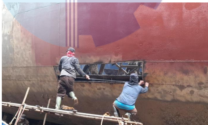
Gambar 2.6 Pembongkaran Plat Lajur Bilga Frame No. 75-80 Kapal Trifosa
