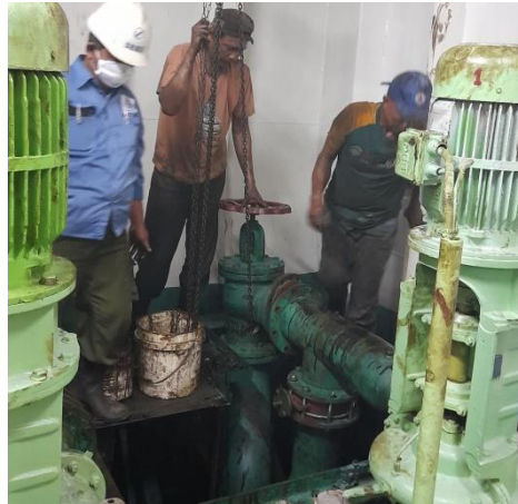
Gambar 2.12 Pembongkaran Pipa Sea Chest
