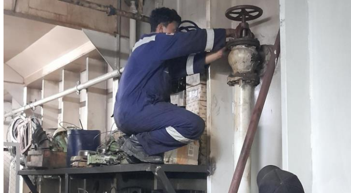
Gambar 2.14 Pemasangan Valve
