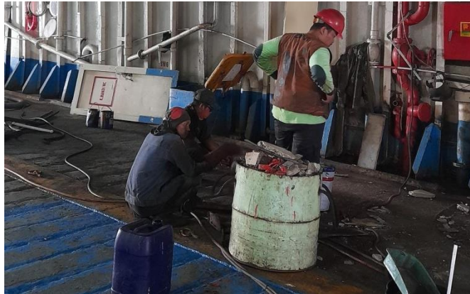
Gambar 2.5 Pekerjaan Lambung bagian Deck KM Kumala
