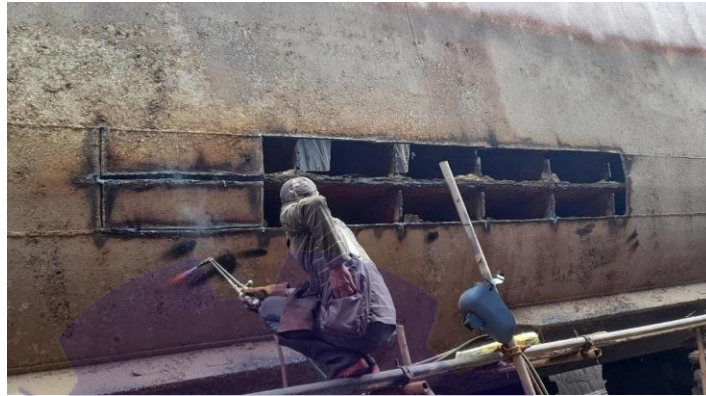
Gambar 2.7 Pembongkaran Plat Lajur Bilga Frame No. 60-65 Kapal Trifosa
