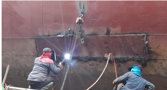
Gambar 2.8 Fit Up Plat Lajur Bilga Frame No. 60-65 Kapal Trifosa
