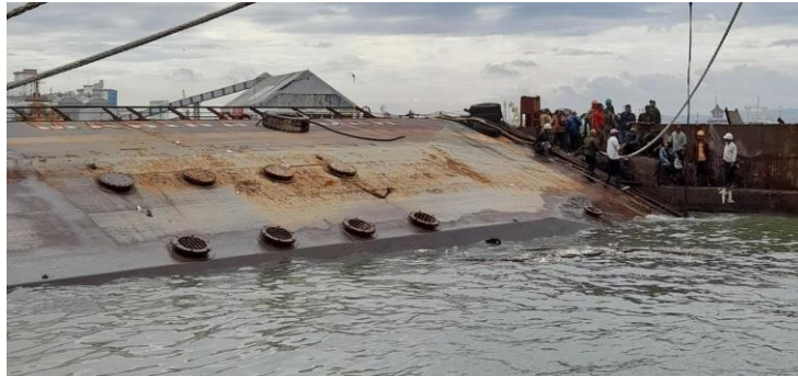
Gambar 2.31 Perbaikan Pintu Graving Dock
