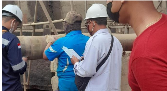
Gambar 3.7 Survey Ukuran OD Shaft di Graving Dock
