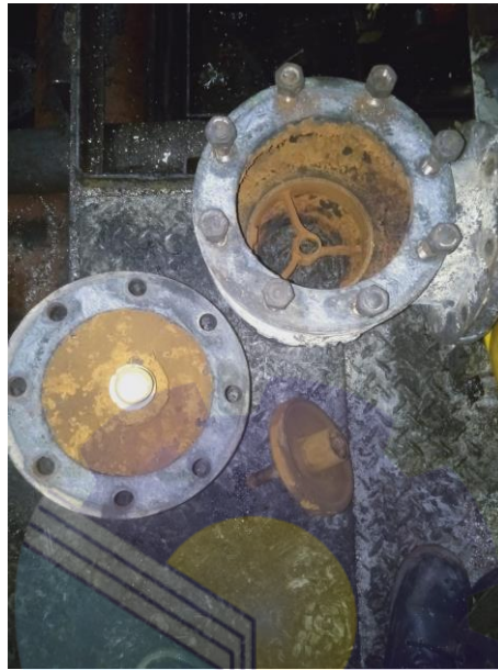
Gambar 2.14 Pembongkaran Valve Kapal Amarelis Indah
