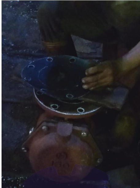
Gambar 2.15 Pembongkaran Skaper Pipa Tinja Kapal Amaris Indah
