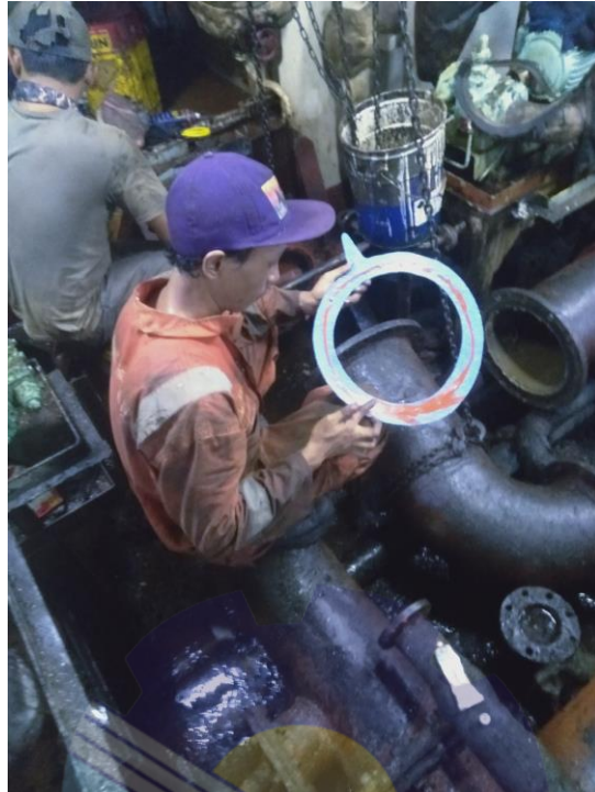
Gambar 3.6 Pemasangan Packing Tambo pada Valve Butterfly 12 Inch Kapal Niki Sae
