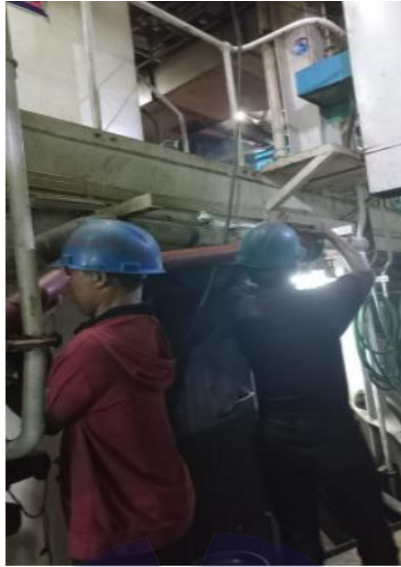
Gambar 2.19 Proses Pemasangan Pipa Udara Kapal Niki Sae
