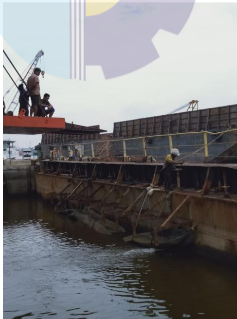
Gambar 2.9 Proses Penutupan Valve Tangki Pintu Dock
