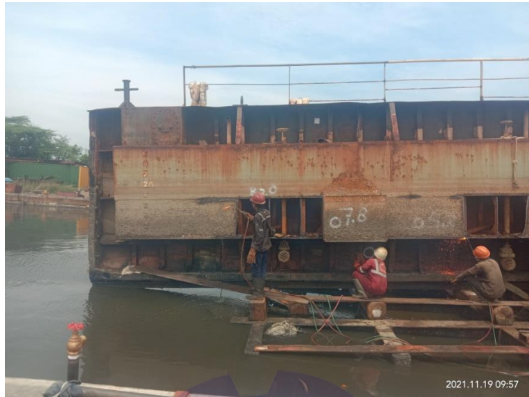
Gambar 2.11 Proses Reparasi Pintu Dock Pembongkaran plat
