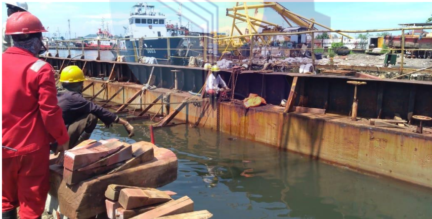
Gambar 2.10 Proses Reparasi Pintu Dock Penutupan Valve Tangki
