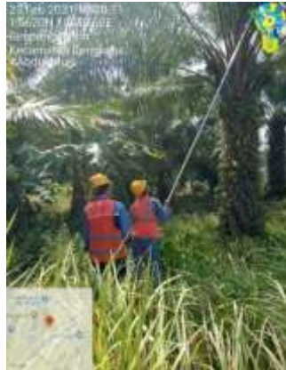
Gambar 2. 4 Pemangkasan atau Pembersihan Jaringan Tegangan Menengah(JTM) (Sumber :PLN. Rayon bengkalis PT. Adra gemilang.2021)
