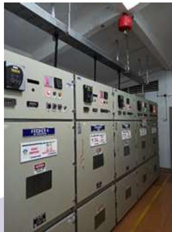
Gambar 2. 28 Beban penyulang (Sumber :PLN. Rayon bengkalis PT. Adra gemilang.2021)
