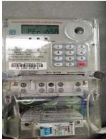
Gambar 2. 32 KWH Meter periksa (Sumber :PLN. Rayon bengkalis PT. Adra gemilang.2021)
