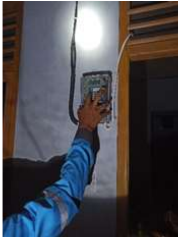
Gambar 2. 20 Mengganti KWH Meter dengan dummy (Sumber :PLN. Rayon bengkalis PT. Adra gemilang.2021)
