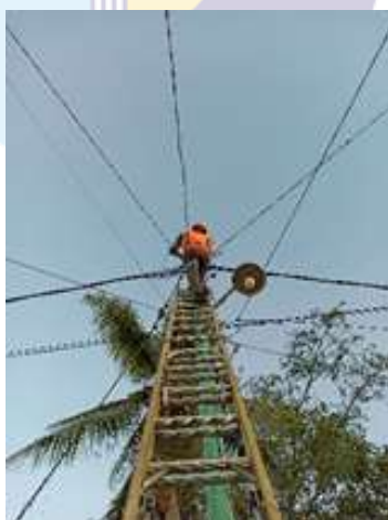
Gambar 2. 25 Penanganan loss kontak (Sumber :PLN. Rayon bengkalis PT. Adra gemilang.2021)
