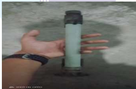
Gambar 2. 17 Mengganti Fuse link yang rusak (Sumber :PLN. Rayon bengkalis PT. Adra gemilang.2021)
