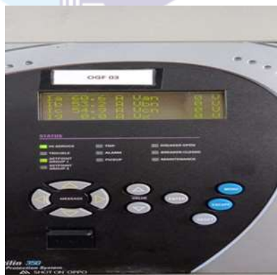
Gambar 2. 29 Beban penyulang (Sumber :PLN. Rayon bengkalis PT. Adra gemilang.2021)
