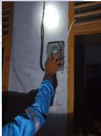
Gambar 2. 5 Penggantian MCB (Sumber :PLN. Rayon bengkalis PT. Adra gemilang.2021)
