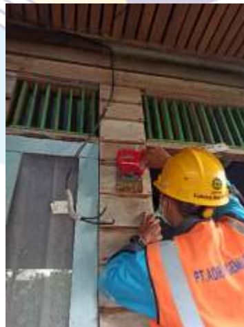
Gambar 2. 13 Mengganti KWH Meter yang rusak dengan dummy (Sumber :PLN. Rayon bengkalis PT. Adra gemilang.2021)
