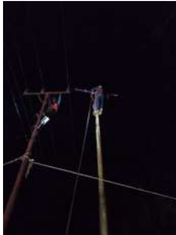
Gambar 2. 8 Penggantian tiang listrik (Sumber :PLN. Rayon bengkalis PT. Adra gemilang.2021)
