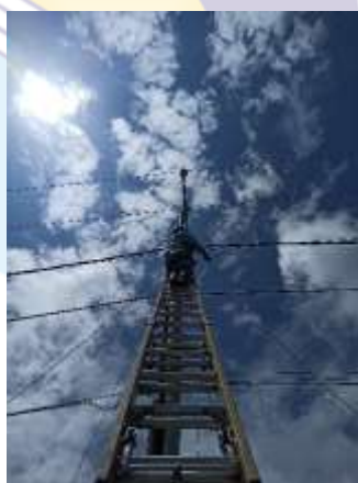
Gambar 2. 35 penggantian kabel SR KWH Meter (Sumber :PLN. Rayon bengkalis PT. Adra gemilang.2021)
