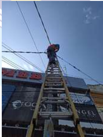
Gambar 2. 15 Pemasangan kabel SR (Sumber :PLN. Rayon bengkalis PT. Adra gemilang.2021)
