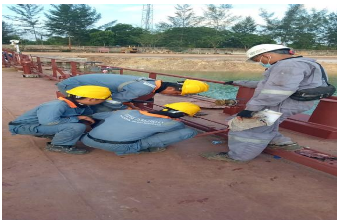
Gambar 2. 11 Sounding tangki bagian kanan
