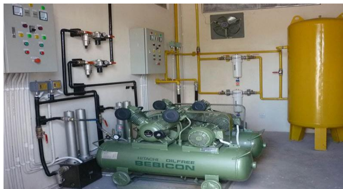
Gambar 2. 14 Commissioning terhadap kompresor
