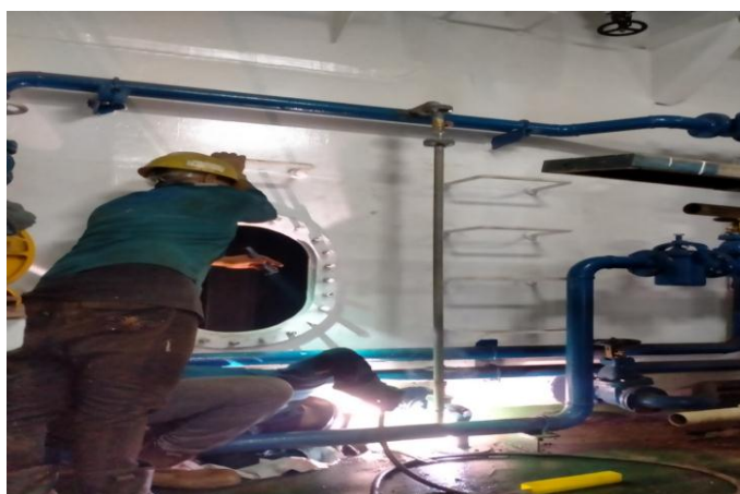
Gambar 2. 75 Pemasangan line pipa
