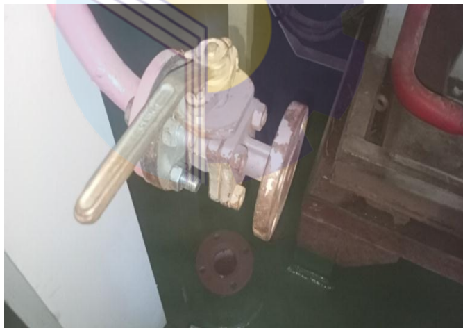
Gambar 2. 47 Valve baru yang sudah diganti
