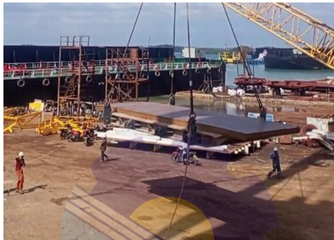
Gambar 2. 32 Proses penurunan rak plat inclining test
