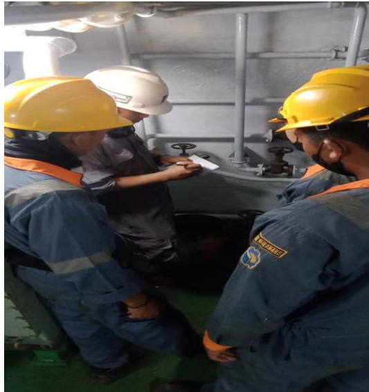
Gambar 2. 6 Pengecekan sistem perpipaan
