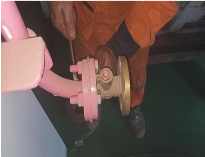
Gambar 2. 46 Kegiatan mengganti valve air compressor
