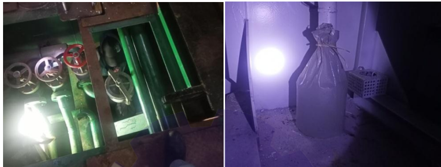
Gambar 2. 50 Pemasangan kantong plastik pada suction bilge
