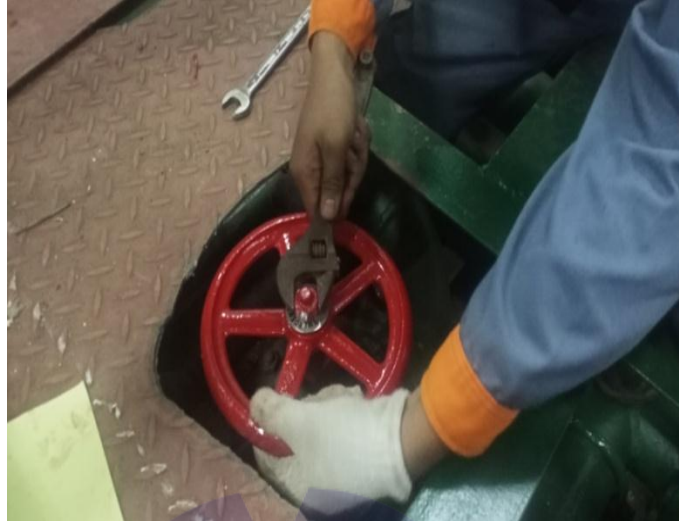
Gambar 2. 42 Pemasangan name plate terhadap handle valve
