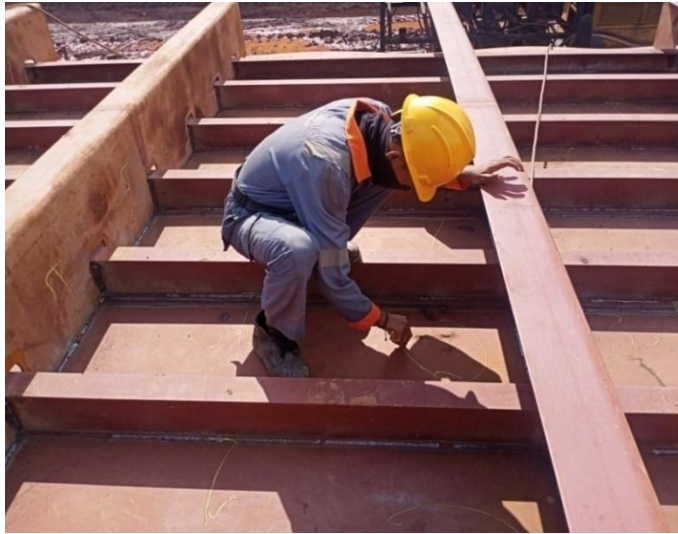
Gambar 2. 35 Proses inspect welding pada bagian bottom
