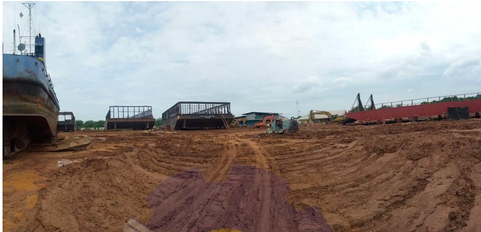
Gambar 1.6 Lahan Galangan Sumber : Dokumentasi pribadi 2021
