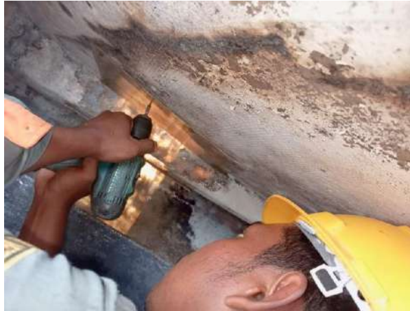
Gambar 2.27 Penempelan menggunakan fiber Sumber: Dokumentasi pribadi 2021
