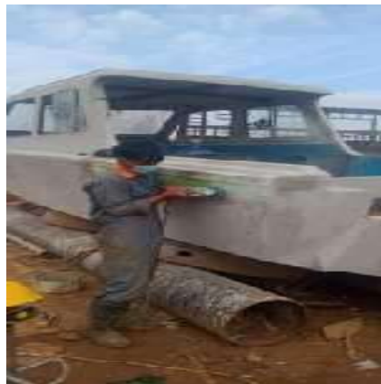
Gambar 2.31 Pekerjaan gerinda pada hasil pendempulan Sumber: Dokumentasi pribadi 2021
