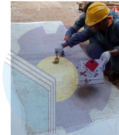
Gambar 3.27 Pembuatan mal Sumber: Dokumentasi pribadi 2021
