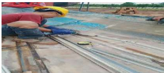
Gambar 2.8 Pemotongan baja ringan untuk gading speed boat Sumber: Dokumentasi pribadi 2021
