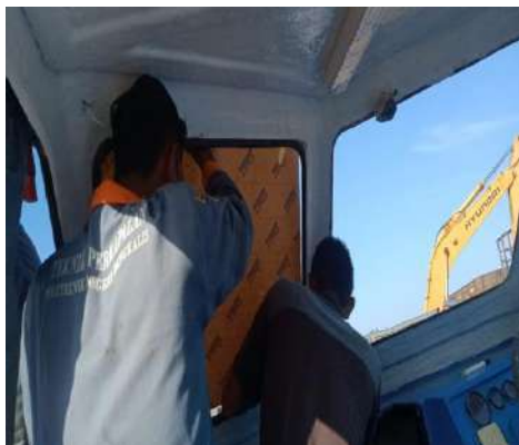
Gambar 2.60 Pemasangan kaca jendela mika / akrilik Sumber: Dokumentasi pribadi 2022
