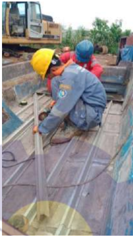
Gambar 2.9 Pemotongan baja ringan Sumber: Dokumentasi pribadi 2021
