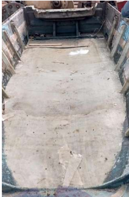
Gambar 3.28 Penampakan lantai yang telah di pasang mal
