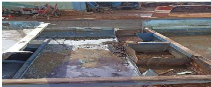
Gambar 2.2 Pembongkaran dan pemotongan gading speed boat Sumber : Dokumentasi pribadi 2021
