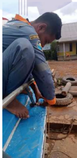
Gambar 2.51 Pemasangan besi relling Sumber: Dokumentasi pribadi 2022
