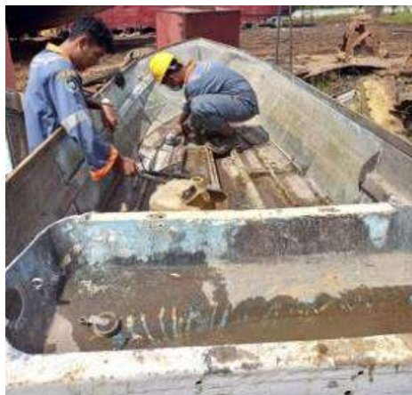
Gambar 2.3 Pemotongan dan pembongkaran lantai speed boat Sumber : Dokumentasi pribadi 2021
