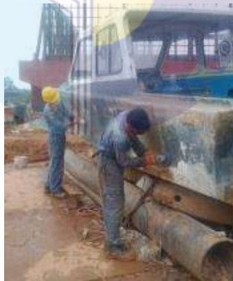
Gambar 2.19 Pekerjaan gerinda pada lambung speed boat Sumber: Dokumentasi pribadi 2021
