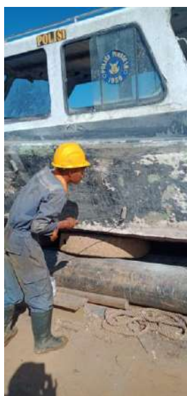
Gambar 2.25 Proses pekerjaan pengecatan
