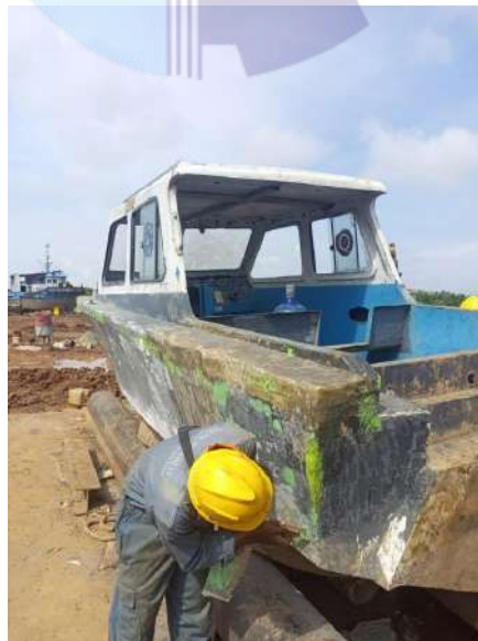
Gambar 2.22 Pekerjaan pedempulan Sumber: Dokumentasi pribadi 2021
