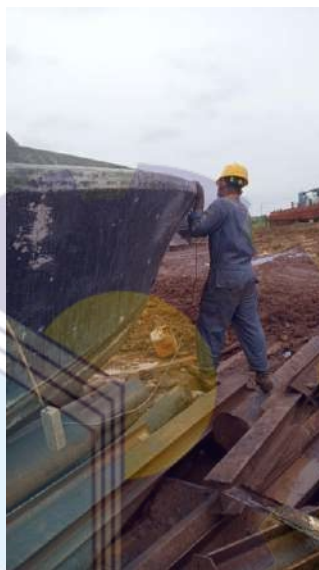
Gambar 2.20 Proses pekerjaan gerinda pada lambung Sumber: Dokumentasi pribadi 2021
