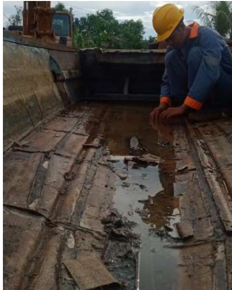
Gambar 3.21 Proses pembersihan lantai Sumber: Dokumentasi pribadi 2021
