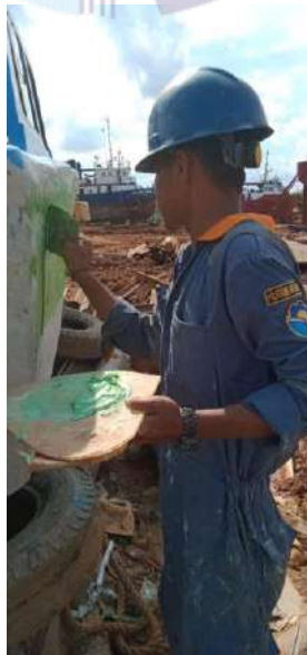
Gambar 2.43 Pekerjaan pendempulan pada lambung speed boat Sumber: Dokumentasi pribadi 2021
