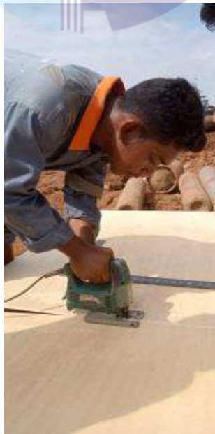
Gambar 2.54 Pemotongan triplek memakai jig shaw Sumber: Dokumentasi pribadi 2022
