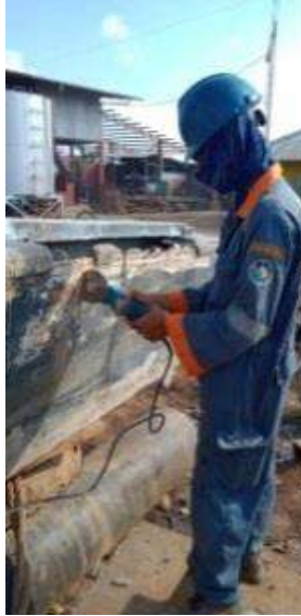
Gambar 2.12 Pemotongan bagian yang rusak Sumber: Dokumentasi pribadi 2021
