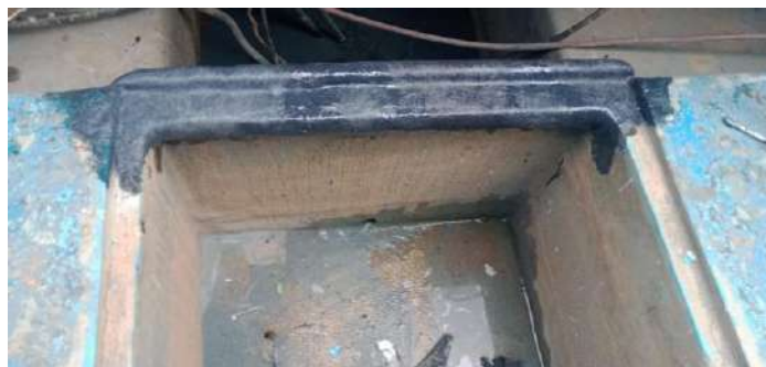
Gambar 2.40 Pekerjaan perbaikan pada bagian dalam Sumber: Dokumentasi pribadi 2021
