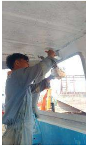
Gambar 2.33 Pengecatan bagian dalam speed boat Sumber: Dokumentasi pribadi 2021
