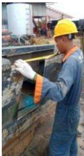
Gambar 2.13 Pengukuran luas area yang rusak Sumber: Dokumentasi pribadi 2021
