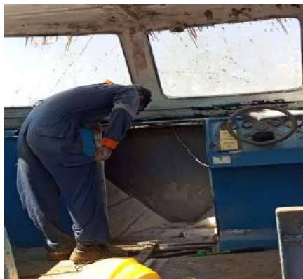
Gambar 2.58 Pemasangan lantai pada speed boat Sumber: Dokumentasi pribadi 2022
