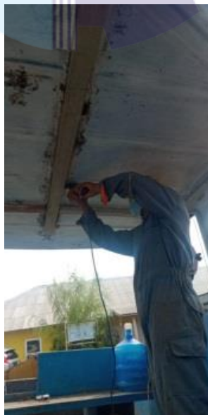
Gambar 2.20 Penggerindaan Area Tidak Rata
