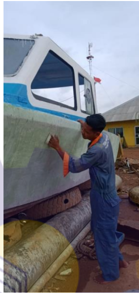
Gambar 3.15 Proses Pengamplasan
