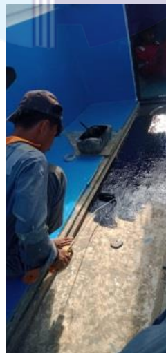
Gambar 2.38 Pengecatan Pada Bagian Lantai Speed Boat
