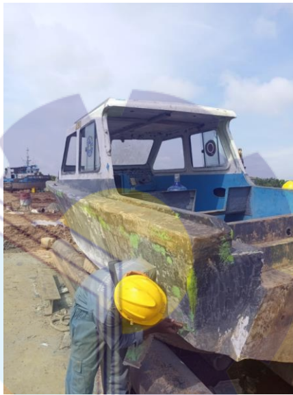
Gambar 2.21 Proses Pendempulan Dibagian Tidak Rata
