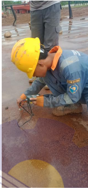
Gambar 2.17 Pengecekan Menggunakan Ultrasonic Test
