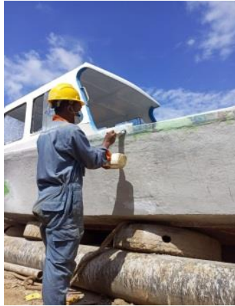
Gambar 2.34 Proses Laminasi
