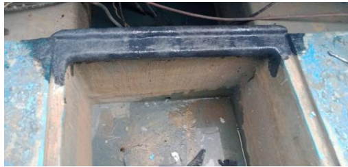
Gambar 2.39 Perbaikan Pada Bagian Yang Rusak
