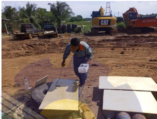
Gambar 2.54 Proses Pelapisan Menggunakan Resin
