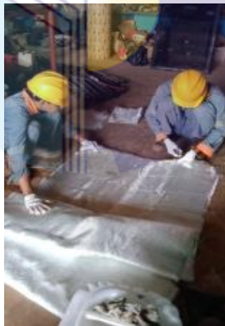
Gambar 2.13 Pemotongan Mat dan WR
