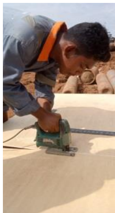
Gambar 2.53 Pemotongan Triplek Menggunakan Jig Shaw .
