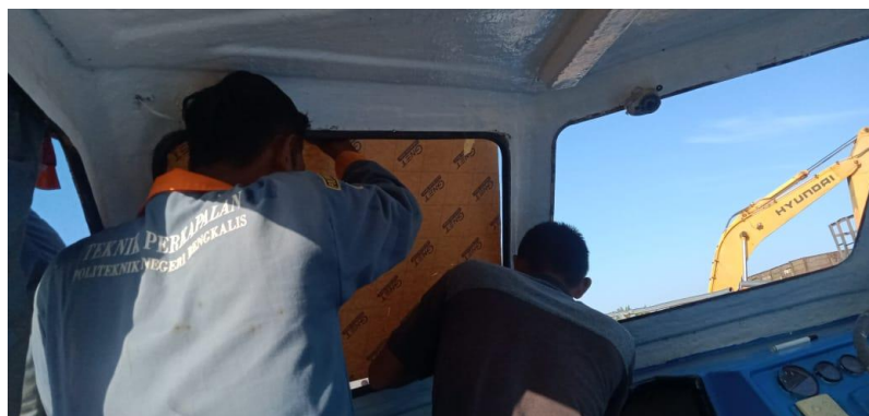
Gambar 2.61 Pemasangan Jendela Speed Boat
