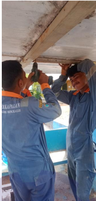
Gambar 3.11 Proses Pemasangan Gading Penguat
