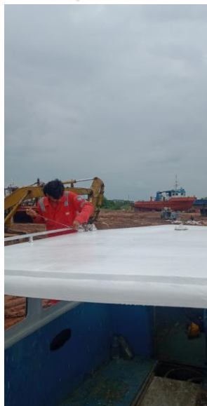
Gambar 3.20 Proses Pengecatan Bangunan Atas
