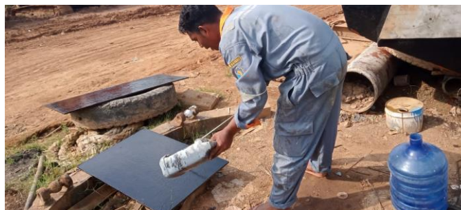
Gambar 2.55 Pengecatan Papan Triplek
