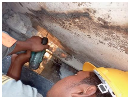
Gambar 2.26 Proses Penempelan Menggunakan Fiber
