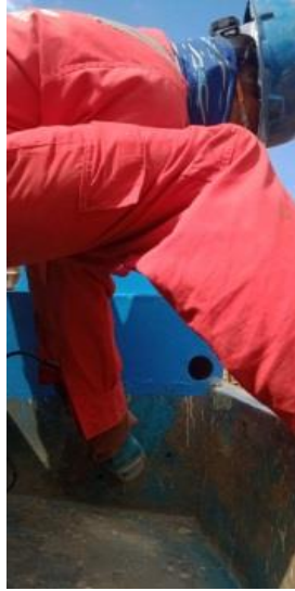
Gambar 2.37 Penggerindaan Bagian Tapak Mesin
