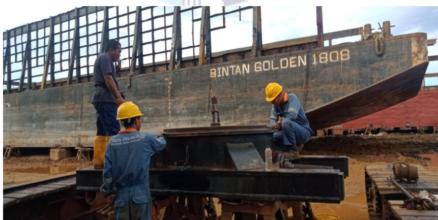
Gambar 2.5 Memperbaiki Slew Ring Excavator
