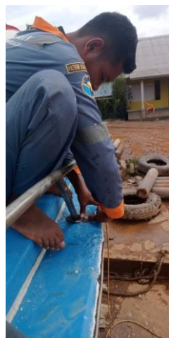
Gambar 2.50 Pemasangan Besi Pagar
