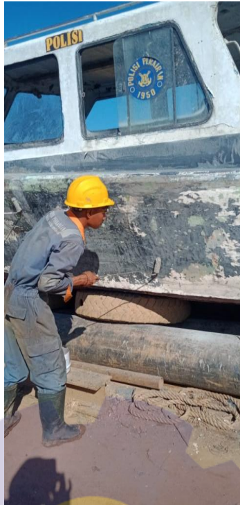
Gambar 2.24 Proses Pengecatan Cat Primer
