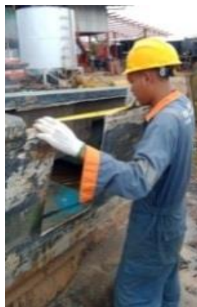
Gambar 2.12 Mengukur Luas Area yang Rusak
