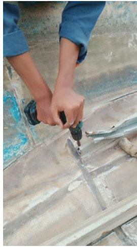
Gambar 2.57 Pemasangan Gading Speed Boat
