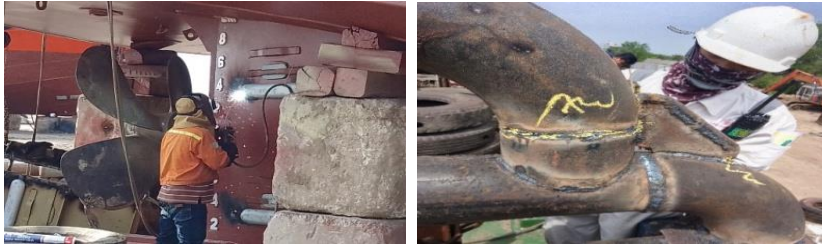
Gambar 2.49 Pemasangan zinc anode dan marking railing tugboat
