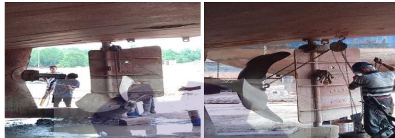
Gambar 3.3 Proses pembongkaran Propeller
