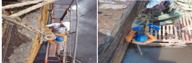
Gambar 2.14 Pemasangan kupingan di kapal tongkang Fenicia 08
