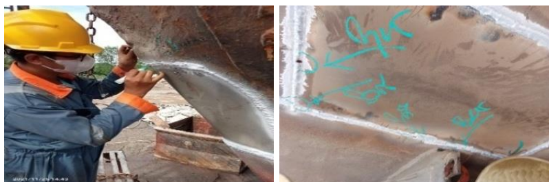
Gambar 2.20 Penetran Test di tugboat nelly 19
