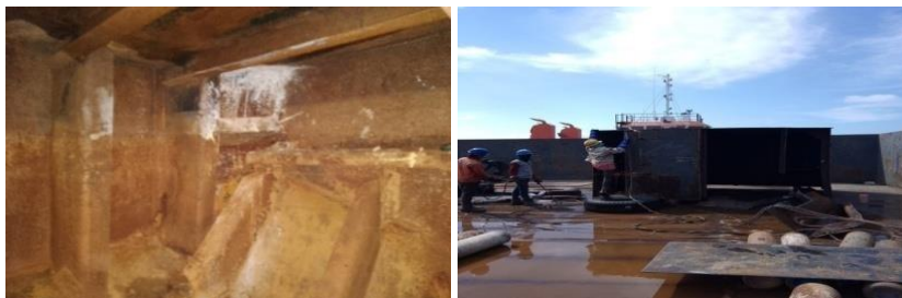
Gambar 2.44 Inspeksi corner main hull & rumah jangkar tongkang
