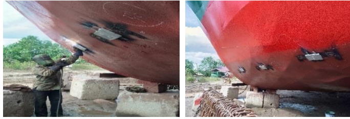
Gambar 2.25 Pemasangan zinc anode
