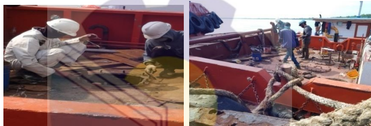
Gambar 2.38 Pemasangan tutup mainhole Tugboat KK 19
