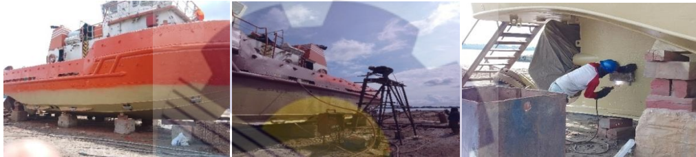
Gambar 2.22 Painting dan pemasangan zinc anode
