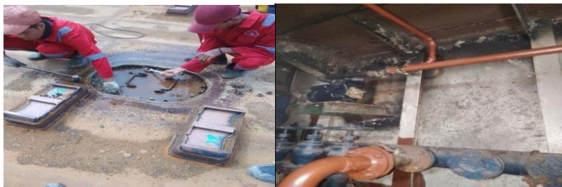
Gambar 2.43 Inspeksi tangki tongkang dan pengukuran instalasi pigtugboat kk 15
