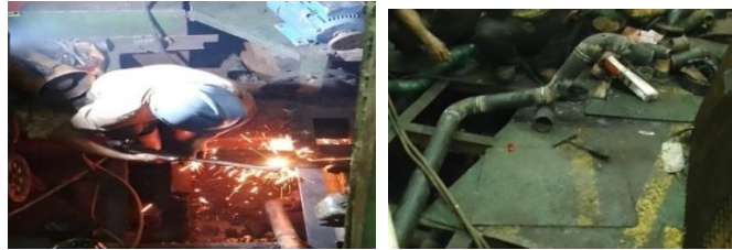
Gambar 2.28 Evaluasi repair pipa kamar mesin kapal SPOB Wijaya Kusuma 3
