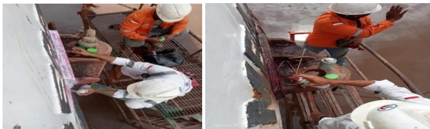
Gambar 2.9 Penetran test pada kapal roro Berembang
