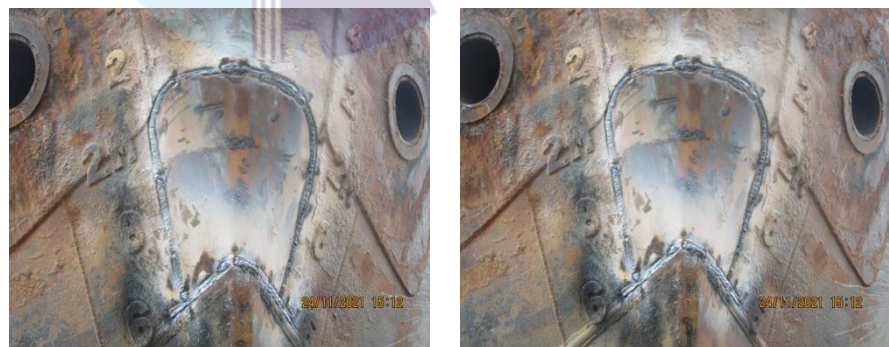
Gambar 3.12 Proses pengelasan
