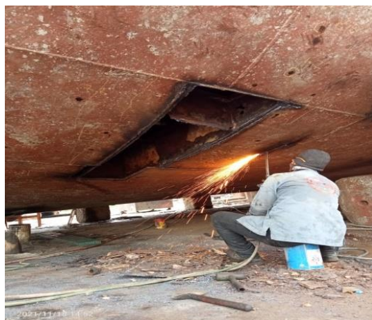
Gambar 2.16 gambar proses replating Roro KMP. Berembang
