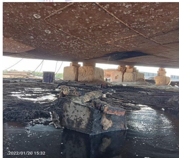
Gambar 2.48 Proses Replating bagian Bottom TB. Sentosa tiga
