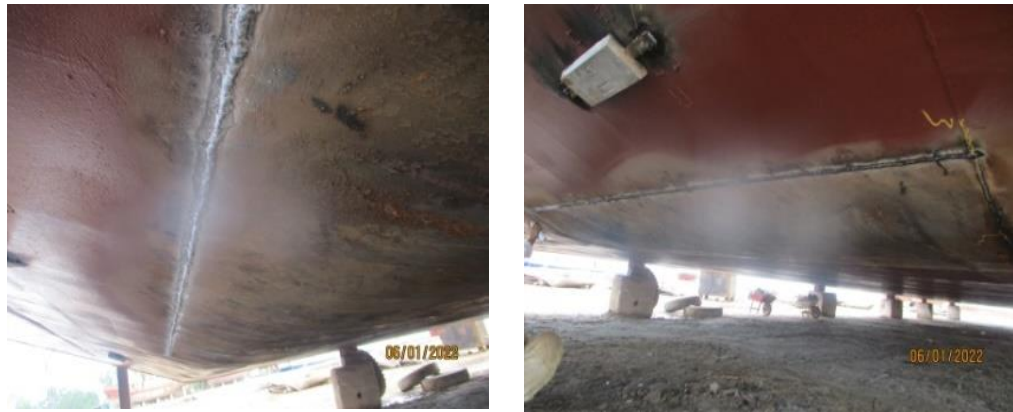
Gambar 2.40 proses Penetrant Test pada BG. Fgs 06
