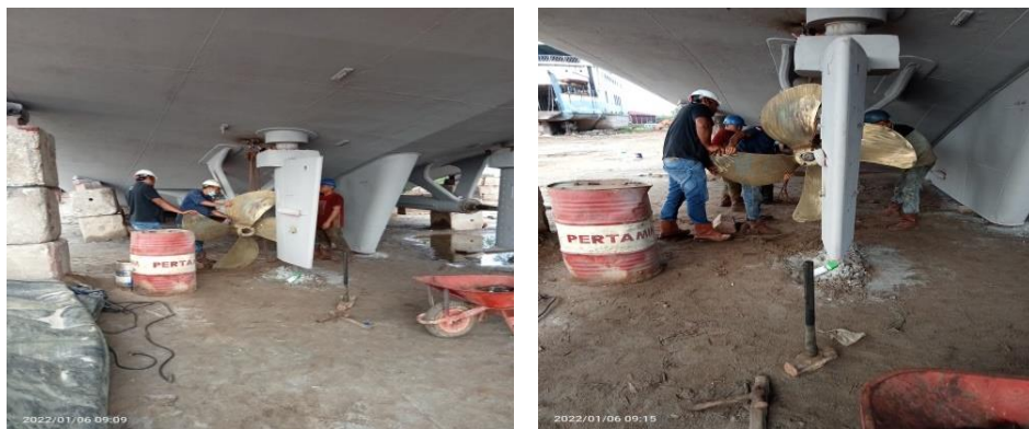
Gambar 2.38 proses pemasangan Propeller Roro KMP Permata Lestari III
