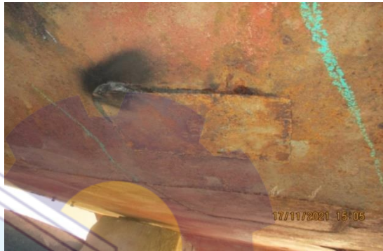
Gambar 3.4 Area yang akan di replating TB. Nelly 19
