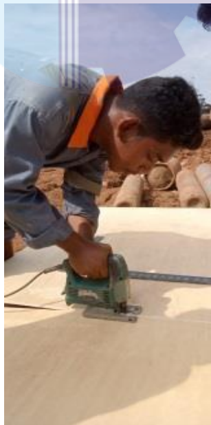
Gambar 2.54 Pemotongan triplek memakai jig shaw
