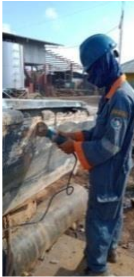
Gambar 2.12 Pemotongan bagian yang rusak
