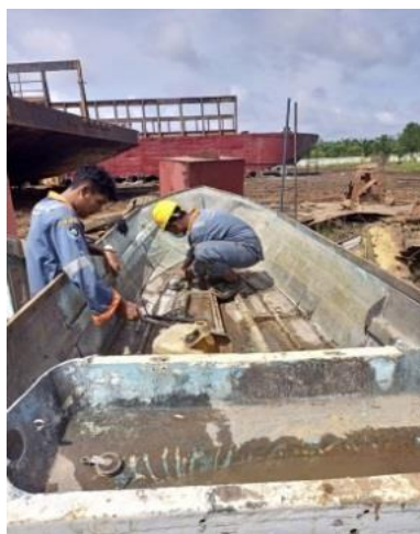
Gambar 2.3 Pemotongan dan pembongkaran lantai speed boat
