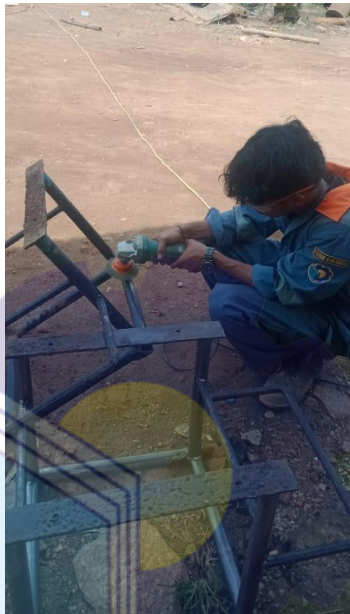
Gambar 2.49 Perbaikan bingkai kursi speed boat
