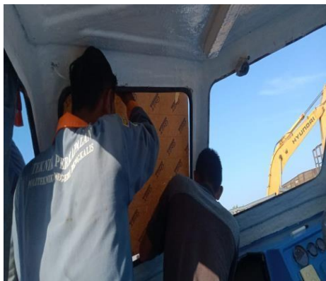
Gambar 2.60 Pemasangan kaca jendela mika / akrilik
