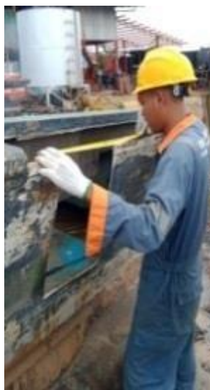
Gambar 2.13 Pengukuran luas area yang rusak
