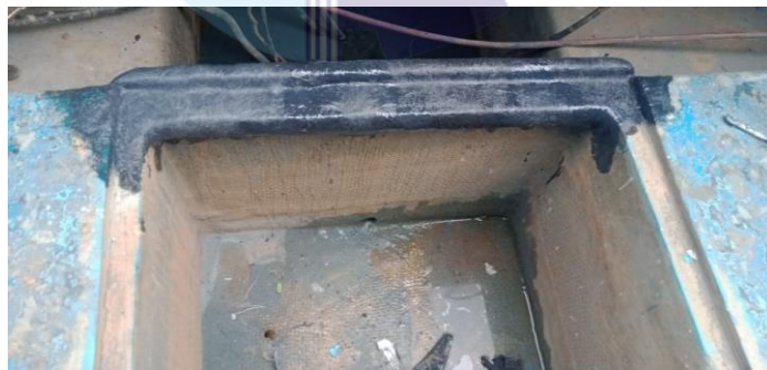
Gambar 2.40 Pekerjaan perbaikan pada bagian dalam
