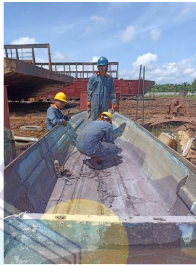
Gambar 2.4 Pemotongan dan pembongkaran lantai speed boat
