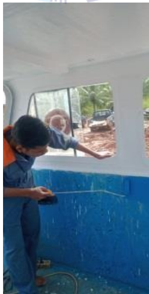
Gambar 2.34 Pekerjaan pengecatan bagian dalam speed boat
