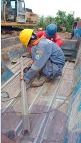
Gambar 2.9 Pemotongan baja ringan
