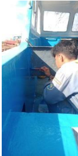
Gambar 2.36 Pengecatan pada bagian belakang kapal
