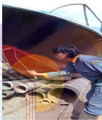
Gambar 3.11 Proses pengecatan lambung kapal.
