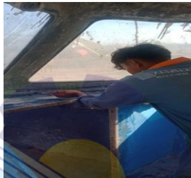
Gambar 3.8 Proses pengecatan bagian dalam bangunan atas kapal
