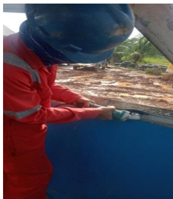
Gambar 3.7 Proses penggrindaan bagian dalam bangunan atas kapal.
