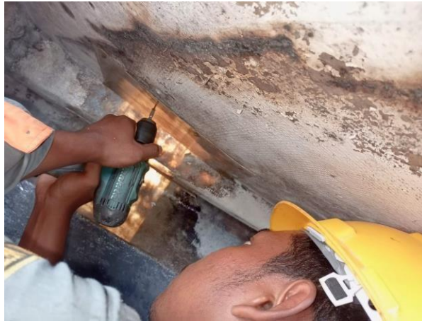
Gambar 2.27 Penempelan menggunakan fiber
