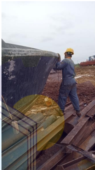
Gambar 2.20 Proses pekerjaan gerinda pada lambung
