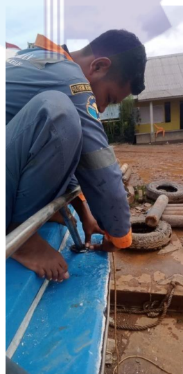
Gambar 2.51 Pemasangan besi telling
