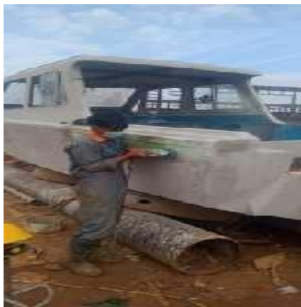
Gambar 2.31 Pekerjaan gerinda pada hasil pendempulan
