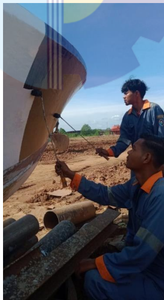
Gambar 2.48 Pengecatan lapisan
