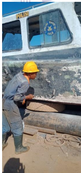
Gambar 2.25 Proses pekerjaan pengecatan
