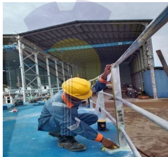
Gambar 2. 16 Pengukuran Pagar Pelindung Kapal Bea Cukai
