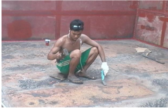
Gambar 3. 3 pengecekan dengan palu
