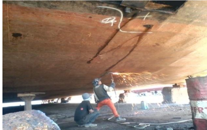
Gambar 3. 6 pemotongan plate
