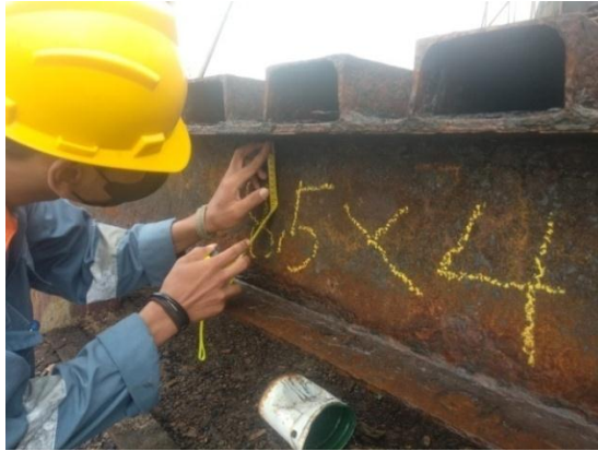
Gambar 2. 15 Pengukuran pada Rampdoor KHB 1805
