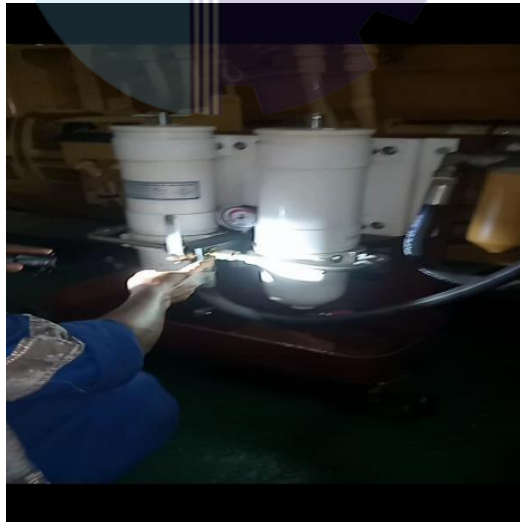
Gambar 2. 44 Pengecekan filter minyak pada main engine
