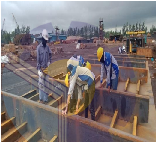
Gambar 2. 9 Inspect wellding di bagian bulkhead
