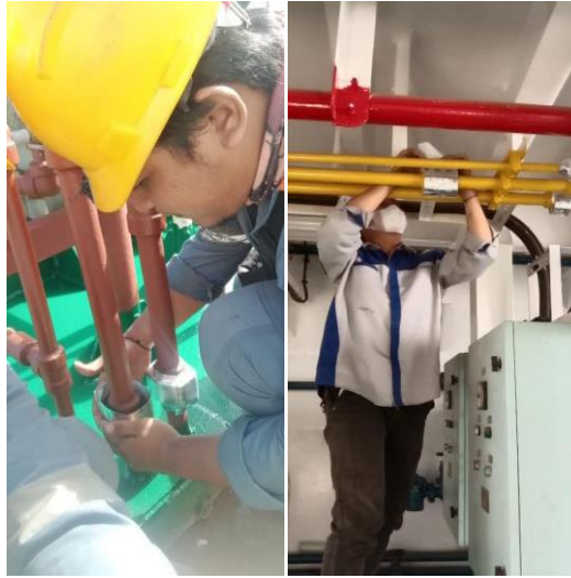
Gambar 2. 40 Pemasangan flash tape
