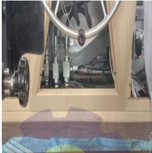
Gambar 2. 35 Valve hidrolik pada navigasi
