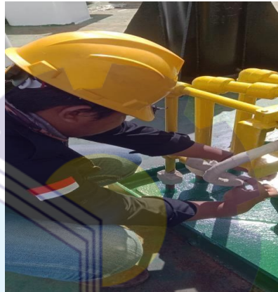
Gambar 2. 42 Pemasangan denso
