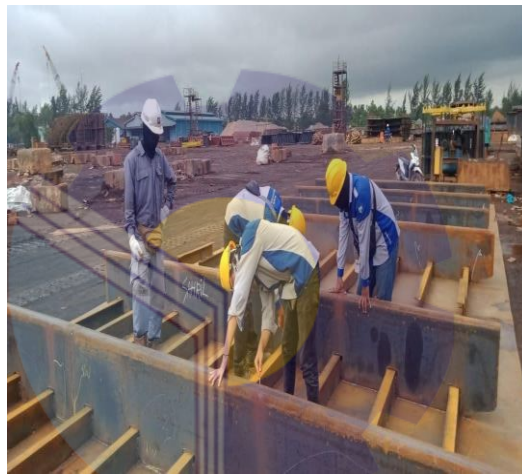
Gambar 2. 9 Inspect wellding di bagian bulkhead
