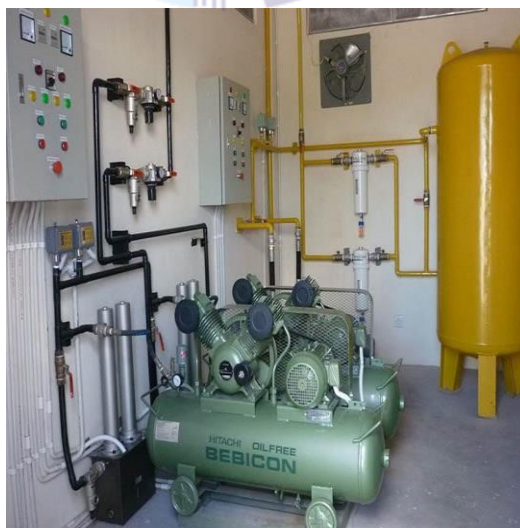
Gambar 2. 14 Compresor pada kapal crane barge
