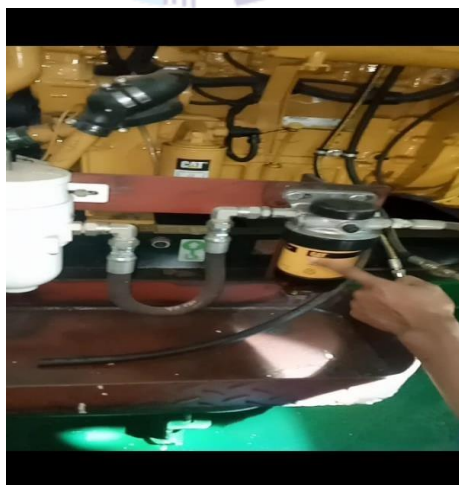
Gambar 2. 45 Pengecekan filter oil pada generator
