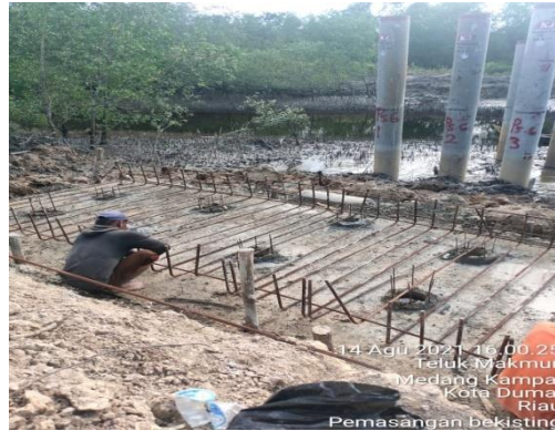
Gambar 3.1.2 Pembuatan Tapak Abutment
