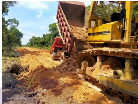
Gambar 3.1.1 alat berat bulldozer (Sumber: Dokumentasi Lapangan)
