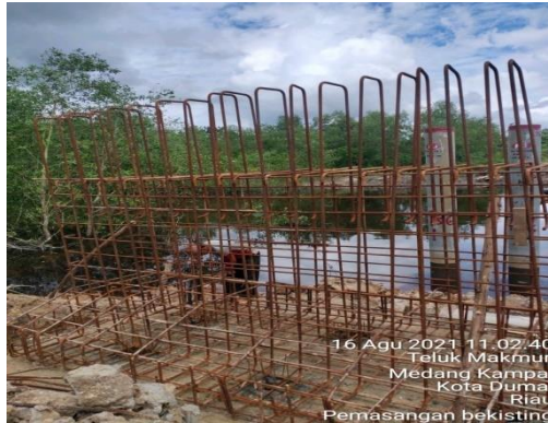
Gambar 3.1.2 Pembesian pada Abutment
