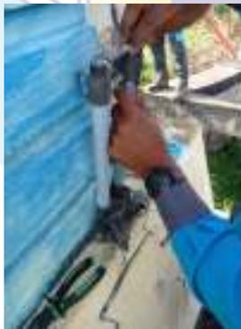
Gambar 2. 23 mengganti fuse link
