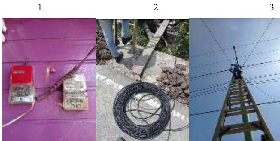
Gambar 2. 28 1. pengantian meter dami, 2. pengantian kabel sr, 3. lost contact
