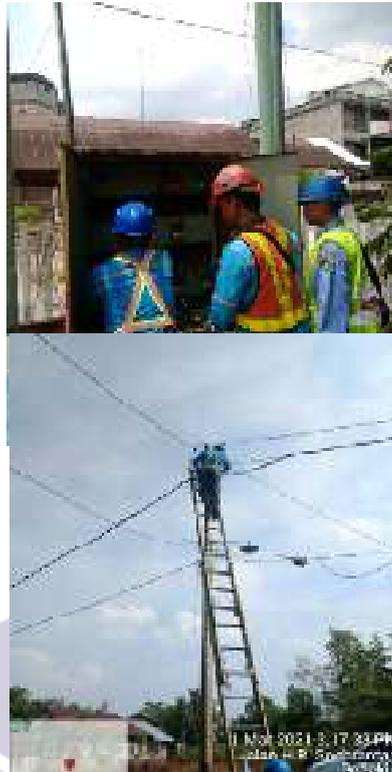
Gambar 2. 71.Perbaikan Casing pada KWH Meter 2.Pengantian MCB pada KWH Meter 3. Pengantian MCB pada KWH Meter4. Memperbaiki kabel Optik pada panel trafo 5. Kwh meter loss kontak
