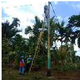
Gambar 2. 17 memperbaiki percing mengakibatkan lost contact
